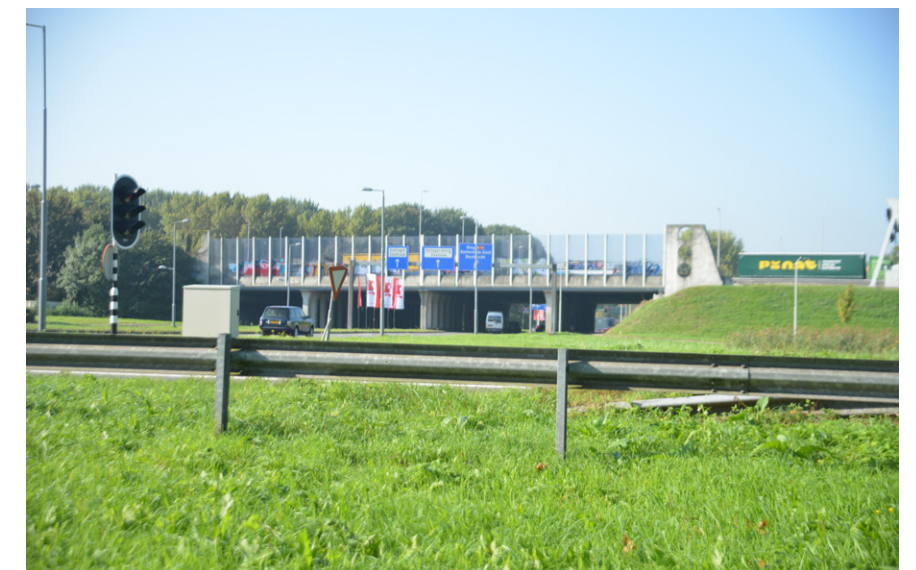
Viaduct van de Hoofdweg
