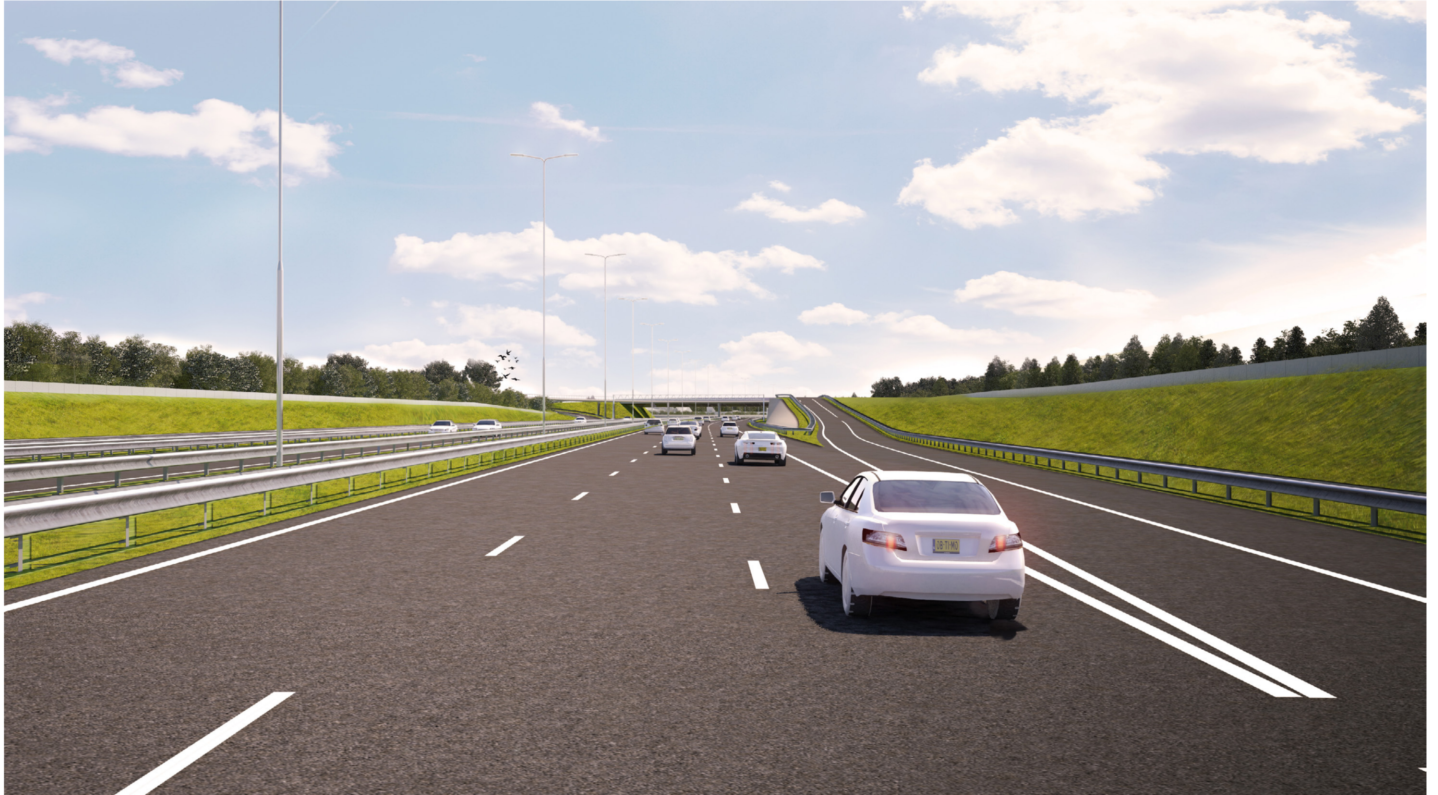
Impressie vanaf de A13/A16 ter plaatse van het akoestisch landschap (hoogte 4,5 meter)
