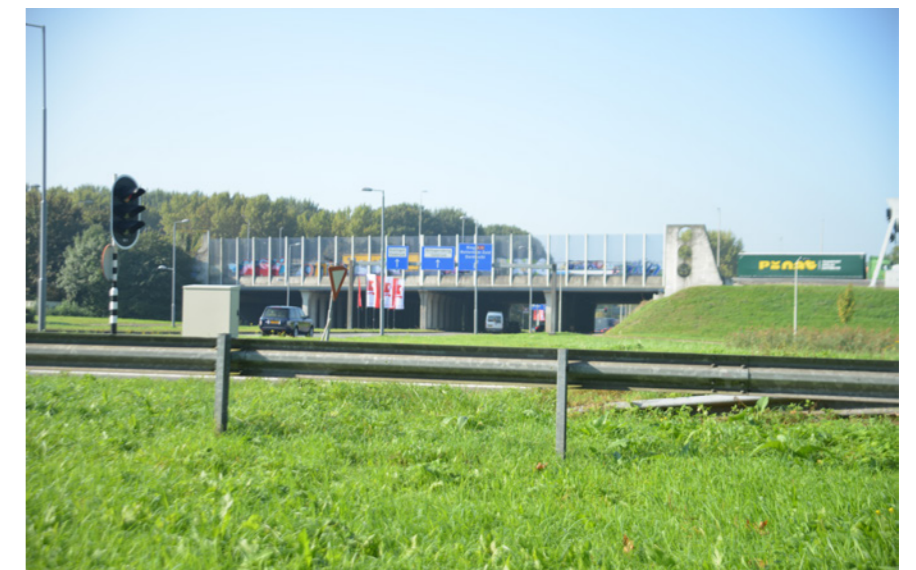
Viaduct van de Hoofdweg
