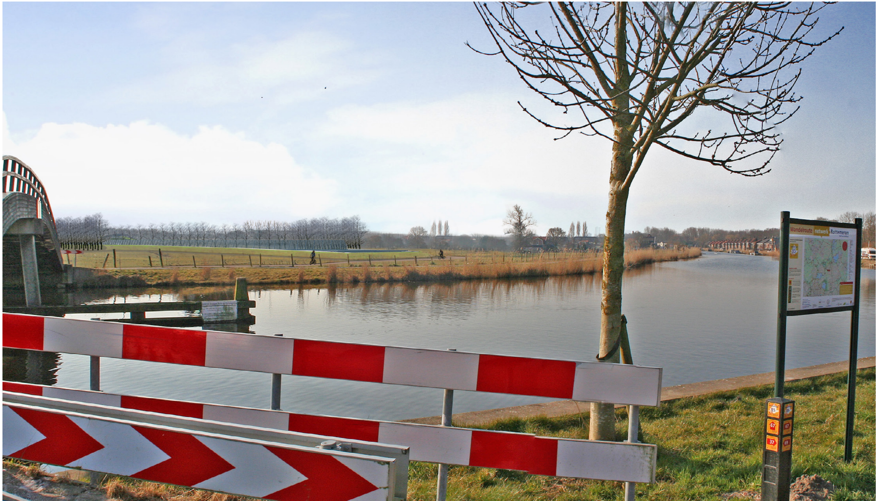
^ Impensie zicht op tunnelmond vanaf de Rottekade
