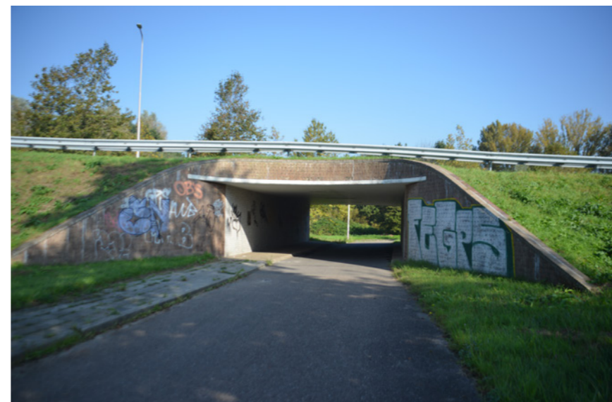
Fietstunneltje onder oprit A16
