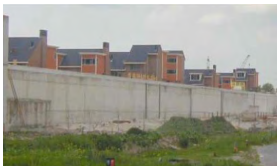
Figuur 5.7.6.1: Project Sijtwende met links de tunnelbak op maaiveld tijdens de bouw, rechts de eindsituatie waarbij woningen rond de tunnelbak zijn gebouwd
