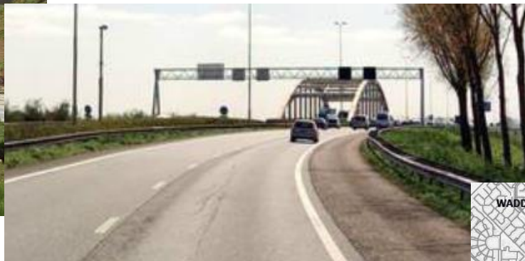
figuur 33: viaduct met boogconstructie
