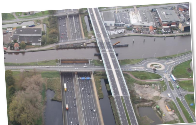
figuur B2.59: Het Gouwe-aquaduct en de nieuwe brug van de parallel structuur over de Gouwe. In het aquaduct liggen (rechts) richting Den Haag 3 stroken (A12) en naar Rotterdam 2 stroken (A20).
