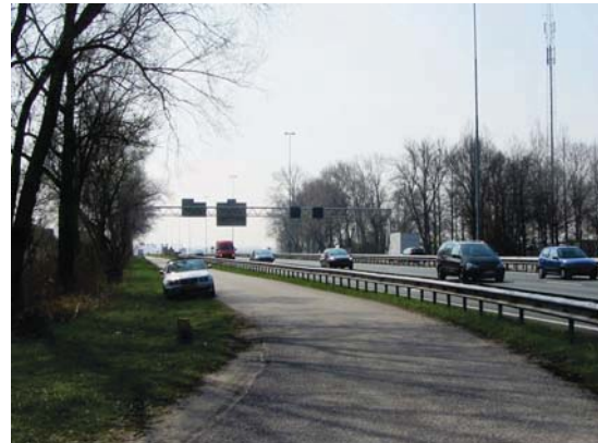
Figuur 14 A27 bij Fort Altena fort moeilijk waarneembaar door beplanting
