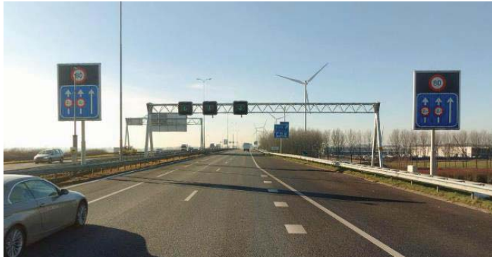
Figuur 3.1: A27 tussen Houten en Nieuwegein met de opengestelde plusstrook
