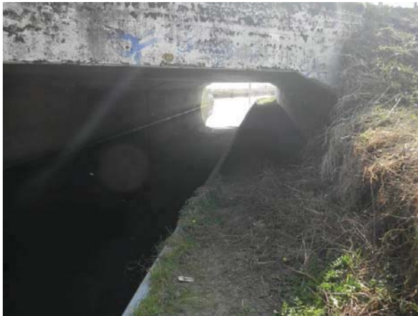
Figuur 12.1: Huidige situatie van het kunstwerk met loopstrook in de Oude Zederik.
