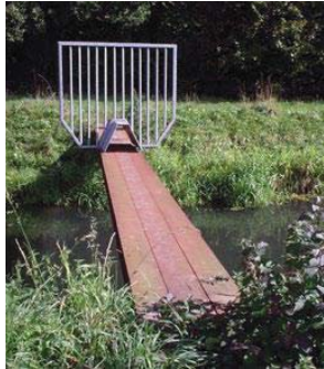
Figuur 12.4: Loopplank voor kleine fauna met voorziening om gebruik door mensen te voorkomen [60].
