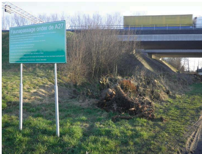
Figuur 4.10 Stobbenwal onder de A27 langs het Merwedekanaal als onderdeel van het MJPO knelpunt UT19.
