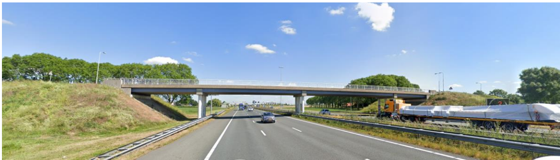
Afbeelding 3.1 Viaduct zonder reservering voor een extra rijstrook (nabij Zaltbommel)
