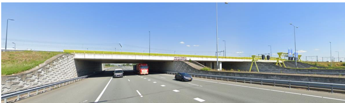
Afbeelding 3.2 Viaduct zonder reservering voor een extra rijstrook (Ring 's-Hertogenbosch)
