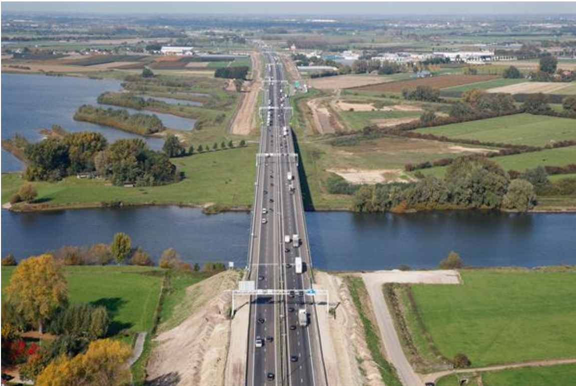
Afbeelding 6.3 Luchtfoto uit 2008 [ https://beeldbank.rws.nl , Rijkswaterstaat / Joop van Houdt], nog zonder geluidschermen op de grondwallen
