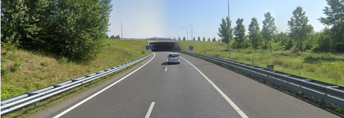
Afbeelding 6.3 Verminderd zicht op een mogelijke file in/na de onderdoorgang in de verbindingsboog Utrecht-Tiel (knp Deil)
