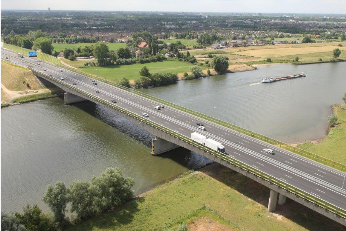
Afbeelding 1.1 Aanzicht Maasbruggen bij Empel (bron: beeldbank.rws.nl, Rijkswaterstaat/Joop van Houdt)
