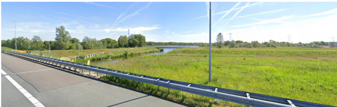
Afbeelding 5.13 Zicht vanaf Ring 's-Hertogenbosch op regionale waterkeringen in oostelijke richting. Links kruising kering en rijbaan, rechts parallel lopende kering (Google Maps)
