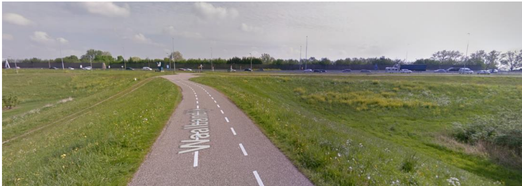
Afbeelding 5.4 Westelijke aansluiting primaire waterkering op landhoofd Waalbrug bij Waardenburg (Google Maps)
