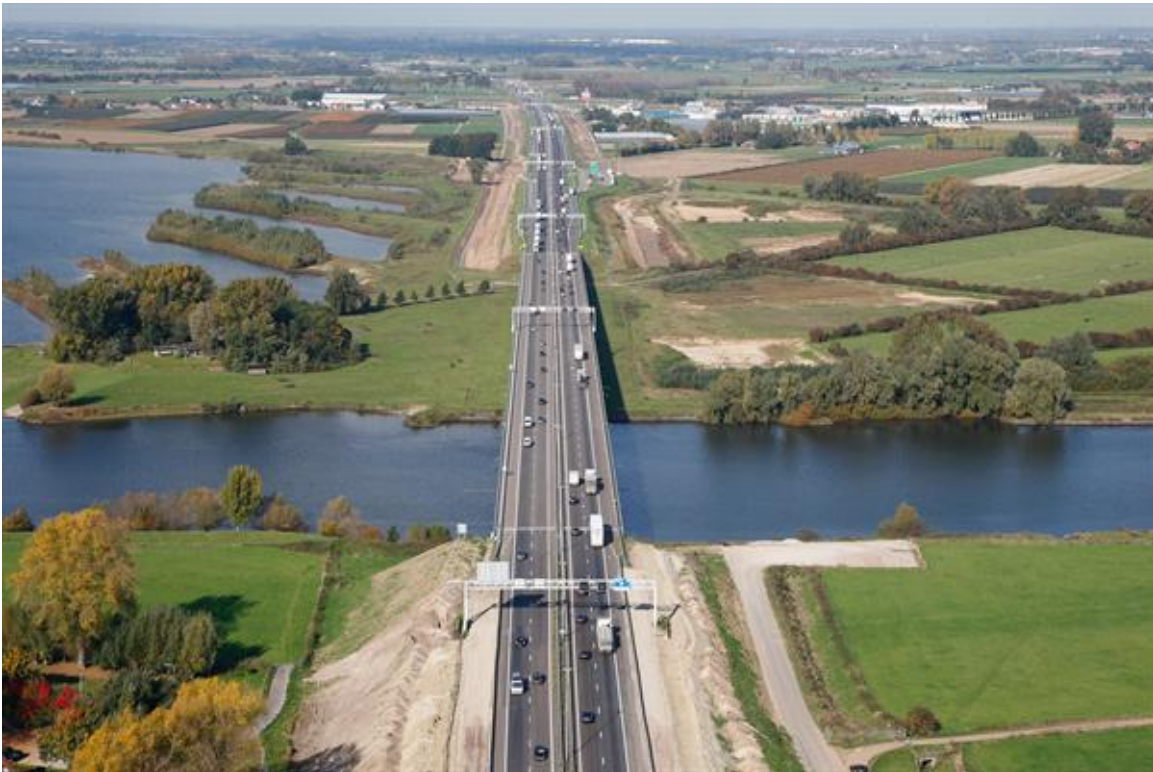
Afbeelding 6.3 Luchtfoto uit 2008 [ https://beeldbank.rws.nl , Rijkswaterstaat / Joop van Houdt], nog zonder geluidschermen op de grondwallen
