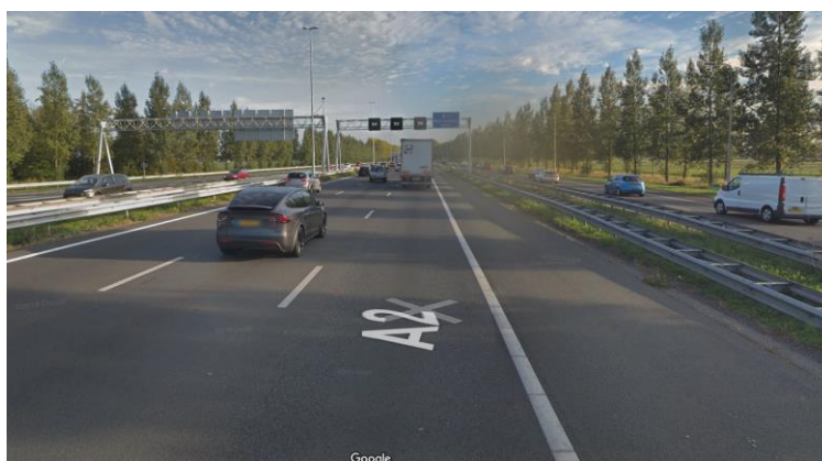
Figuur 4-2 A2 bij Kp Deil in zuidelijke richting (Google oktober 2018)
