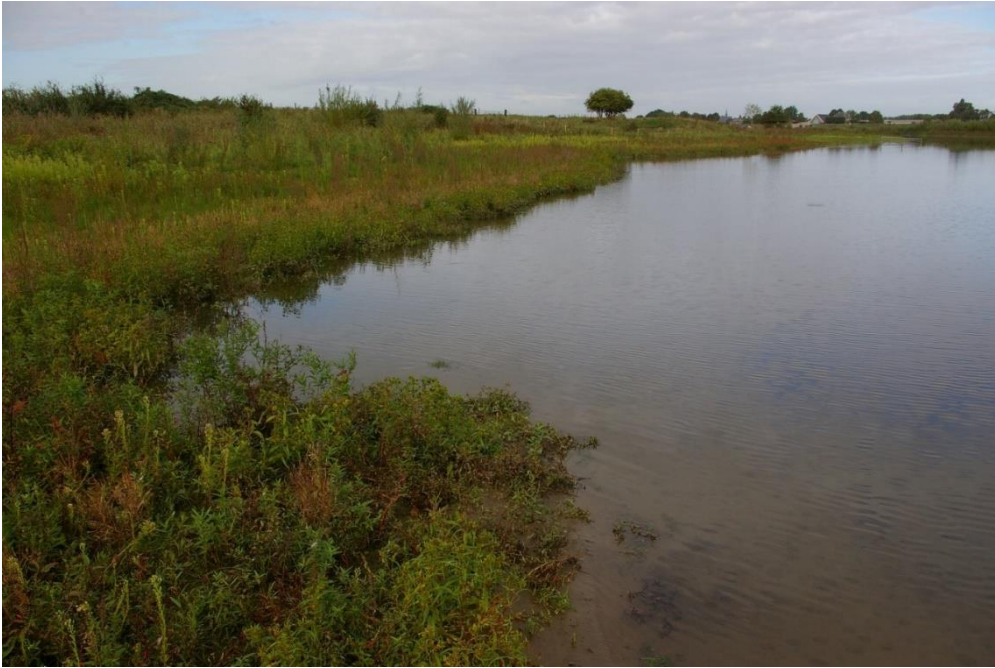
Figuur 13 De gerealiseerde KRW-geul in de Doornwaard met geleidelijk oplopend talud.
