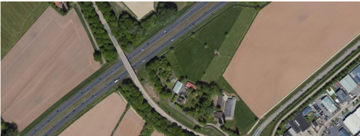
Figuur 7.5.7. Woningbouw bij 137,2
