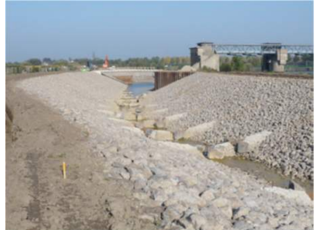
Foto 8 Drempels van stalen damwand in de vispassage bij Borgharen (links: voor aanstorten, rechts: na afwerking)
