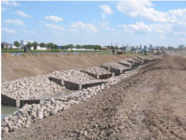
Foto 8 Drempels van stalen damwand in de vispassage bij Borgharen (links: voor aanstorten, rechts: na afwerking)
