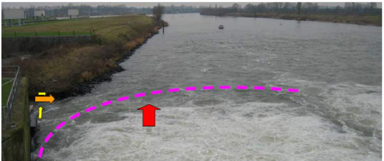
Figuur 59 Ingang vispassage bij stuw Sambeek. De stroomsnelheden in het midden van de uitstroom van de vistrap bedragen 0,5-0,7 m/s (oranje pijl), aan de ondiepe zijde van de vistrap is de stroomsnelheid 0,3-0,4 m/s (gele pijlen). In het stroombed ter hoogte van de vistrap bedroeg de stroomsnelheid 1-1,2 m/s (rode pijl). De roze stippelij is de fictieve migratielinielij voor relatief zwakke zwemmers (bron: Kranenbarg & Kemper, 2006).
