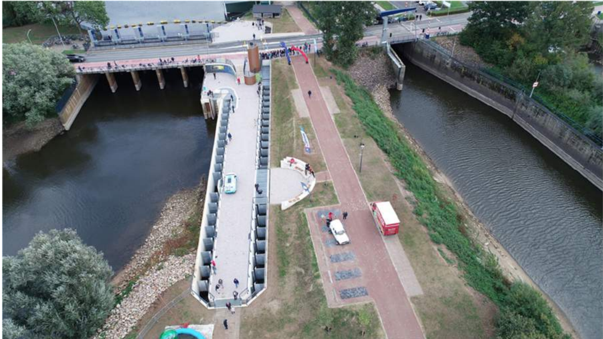
Figuur 79 Vertical slot vispassage te Doesburg (bron: Waterschap Rijn en IJssel).
