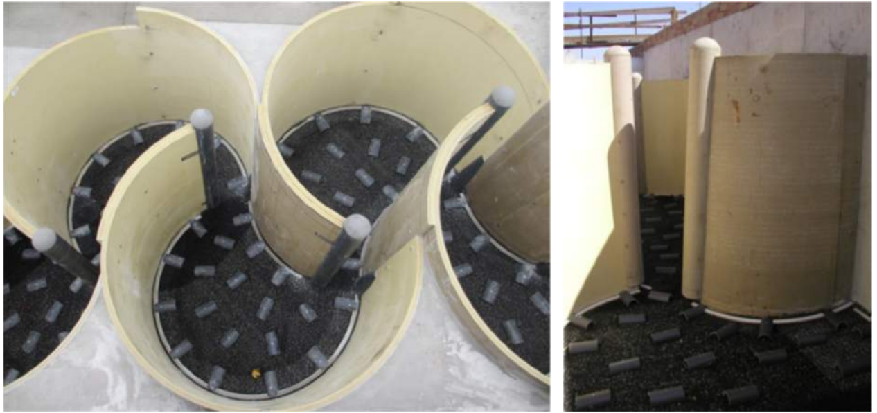
Foto 10 Bovenaanzicht (links) en vooraanzicht (rechts) van de Mäander vispassage.
