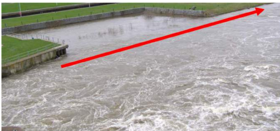
Figuur 62 Stromingsbeeld benedenstrooms van de stuw bij Sambreek: rechter Stoney onderlossend (rode pijl, stroomafwaarts gerichte stroming).
