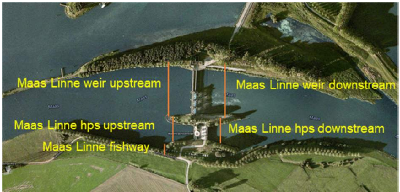
Figuur 45 Ligging van de detectiestations (rode lijnen) bij het stuwcomplex van Linne (rechts: benedenstrooms).
