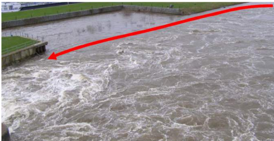
Figuur 61 Stromingsbeeld benedenstrooms van de stuw bij Sambreek: rechter Stoney onderlossend (rode pijl, retourstroming)
