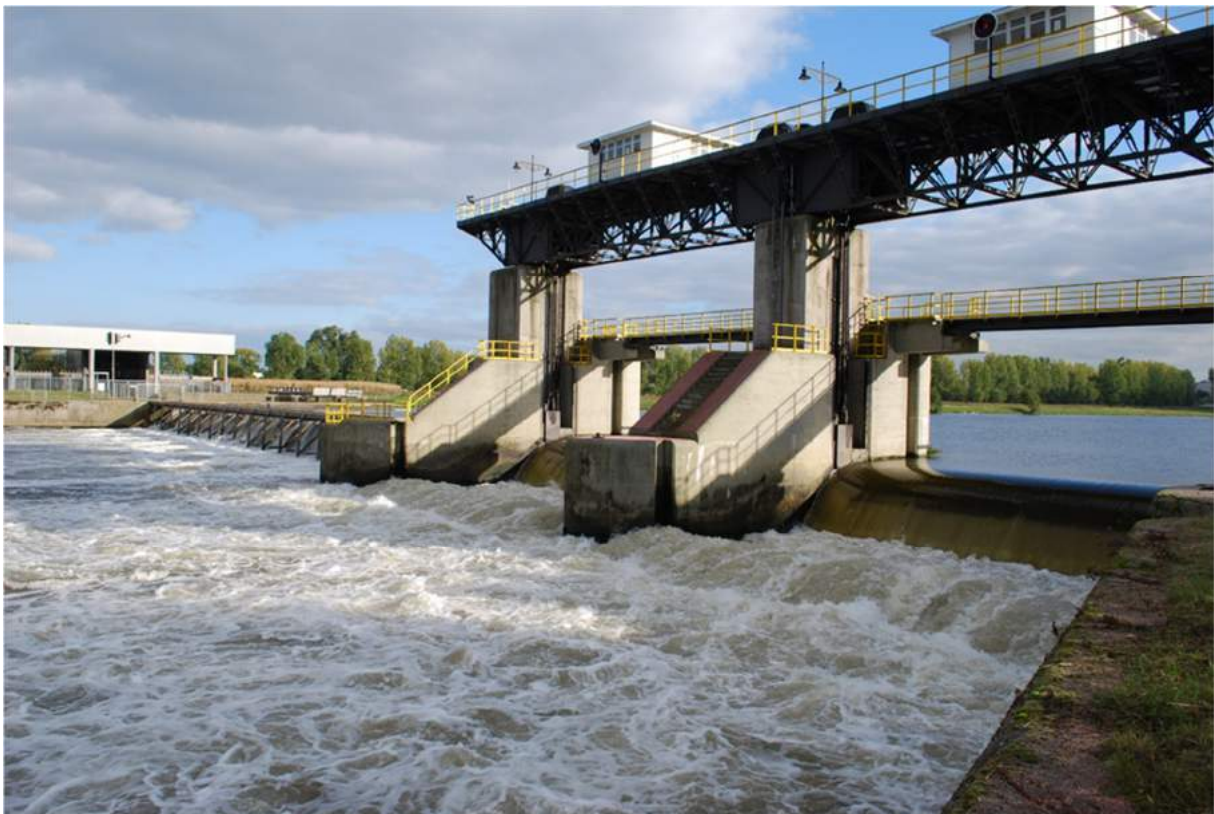
Foto 9 Stromingsbeeld benedenstrooms van de stuw bij Roermond bij hoge afvoer ((foto: F.T. Vriese, ATKB).
