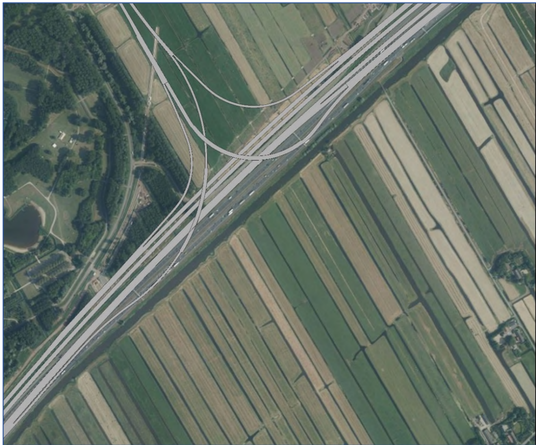
Figuur 1-2 Vormgeving van de rijbanen bij knooppunt Hofvliet met de verplaatsing van de A4
