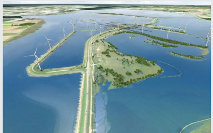
Windpark Krammer (N257)
