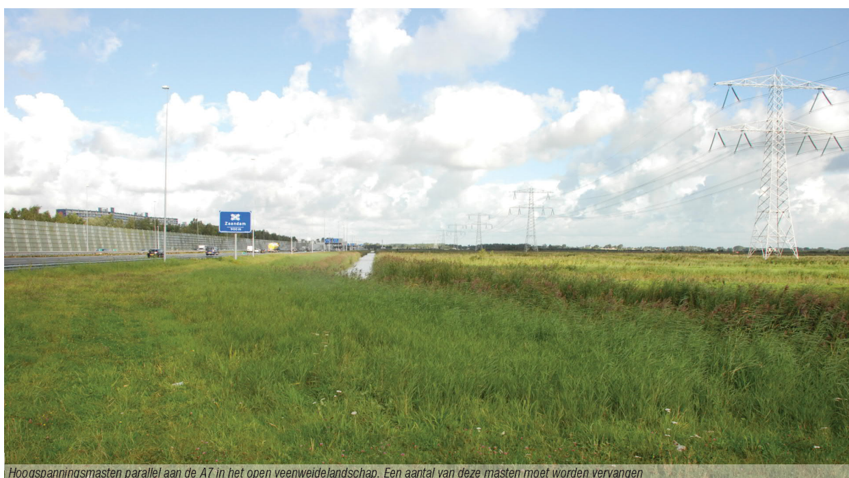
Hoogspanningsmasten parallel aan de A7 in het open veenweidelandschap. Een aantal van deze masten moet worden vervangen
