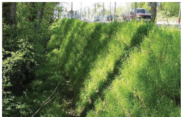
Talud/grondkerende constructie naast fietspad A7 heeft groene uitstraling
