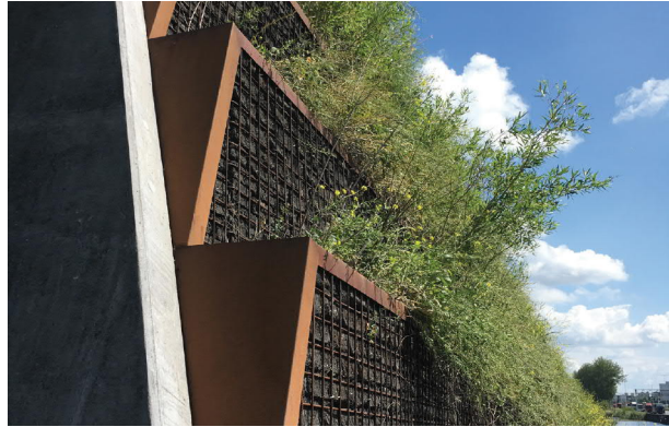
Grondkerende constructie bij Kon. Julianalaan heeft groene uitstraling middels bijv. het toepassen van bioblocks in (corten stalen) getrapte bakken.
