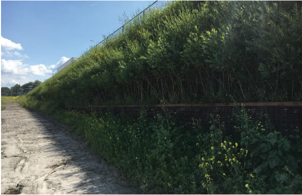
Grastalud snelweg naast fietspad oostzijde knooppunt
