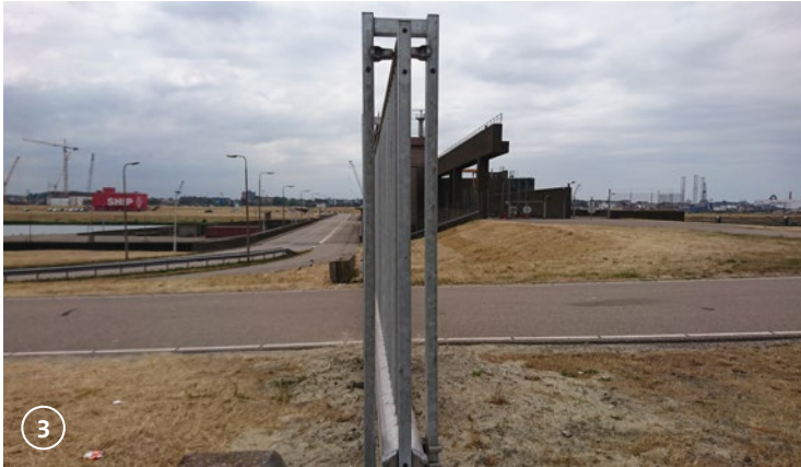
Aan de westzijde maakt de dijk een knik en loopt tegen het gebouw van de Spuisluis. Ter hoogte van de knik loopt een weg naar het vooreiland.
