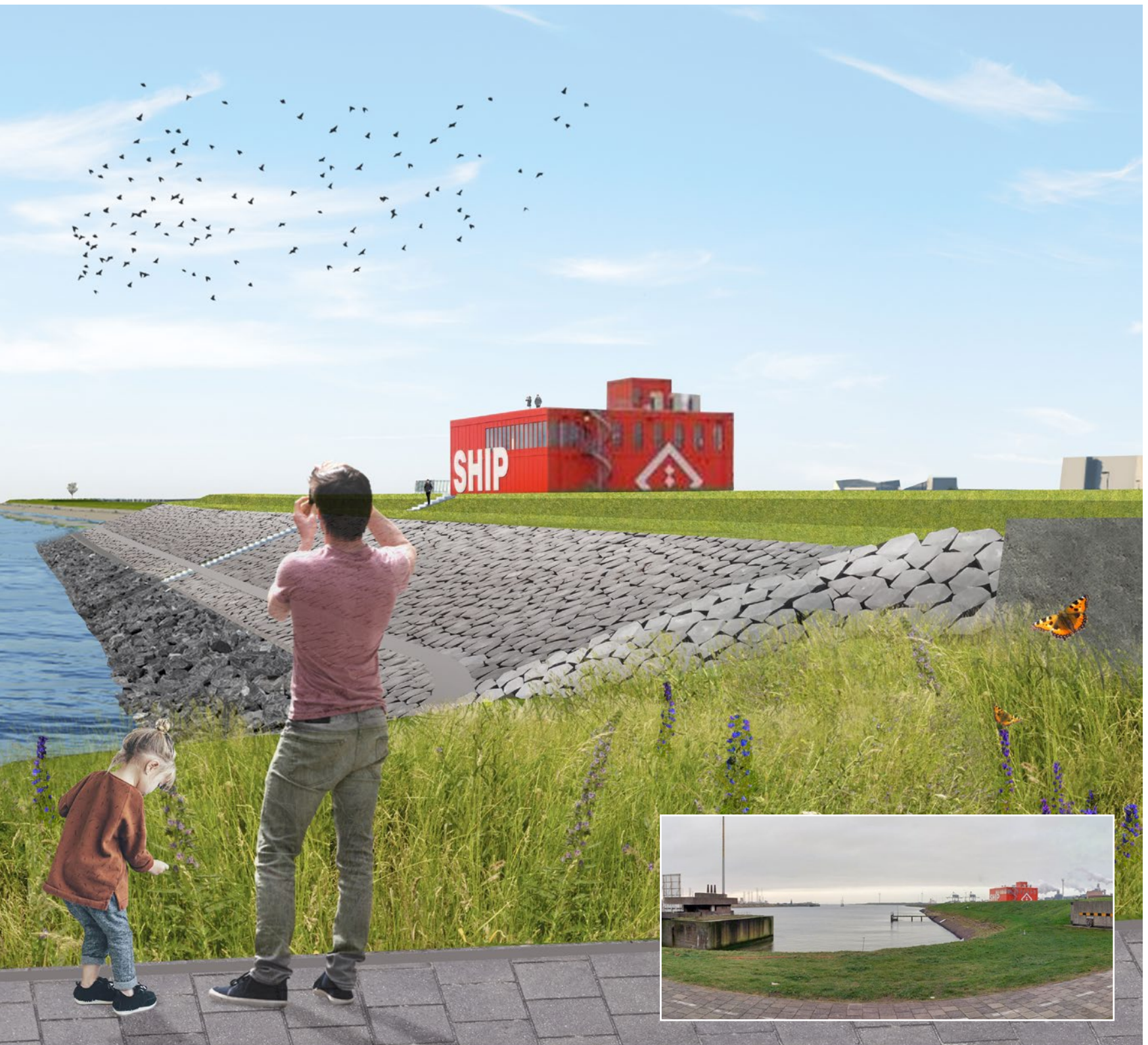
Foto huidige situatie - in westelijke richting kijkend langs het te versterken dijktraject
