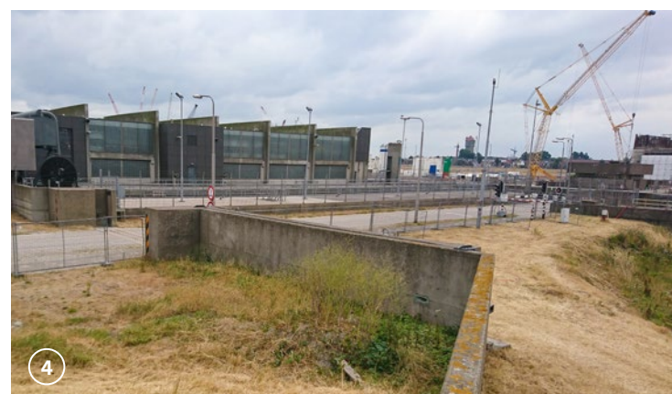
bij de Noordersluis snijdt het dijklichaam in een keermuur die de waterkering vormt. Aan de buitendijkse zijde is een roldeur aanwezig die bij hoogwater in de coupure gerold kan worden.
