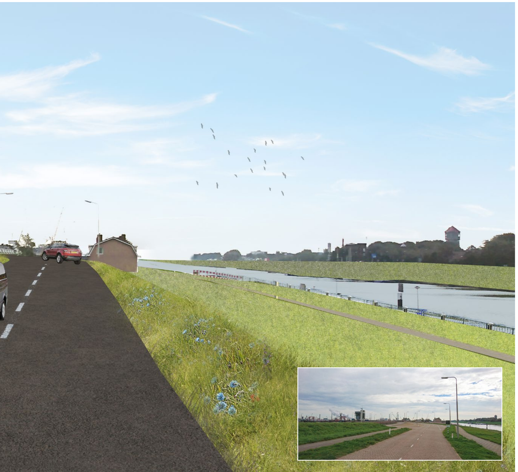
Foto huidige situatie - in oostelijke richting kijkend richting de Middensluis
