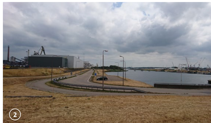
De oever van het Binnenspuikanaal heeft een klein talud en gaat over in een damwand.
