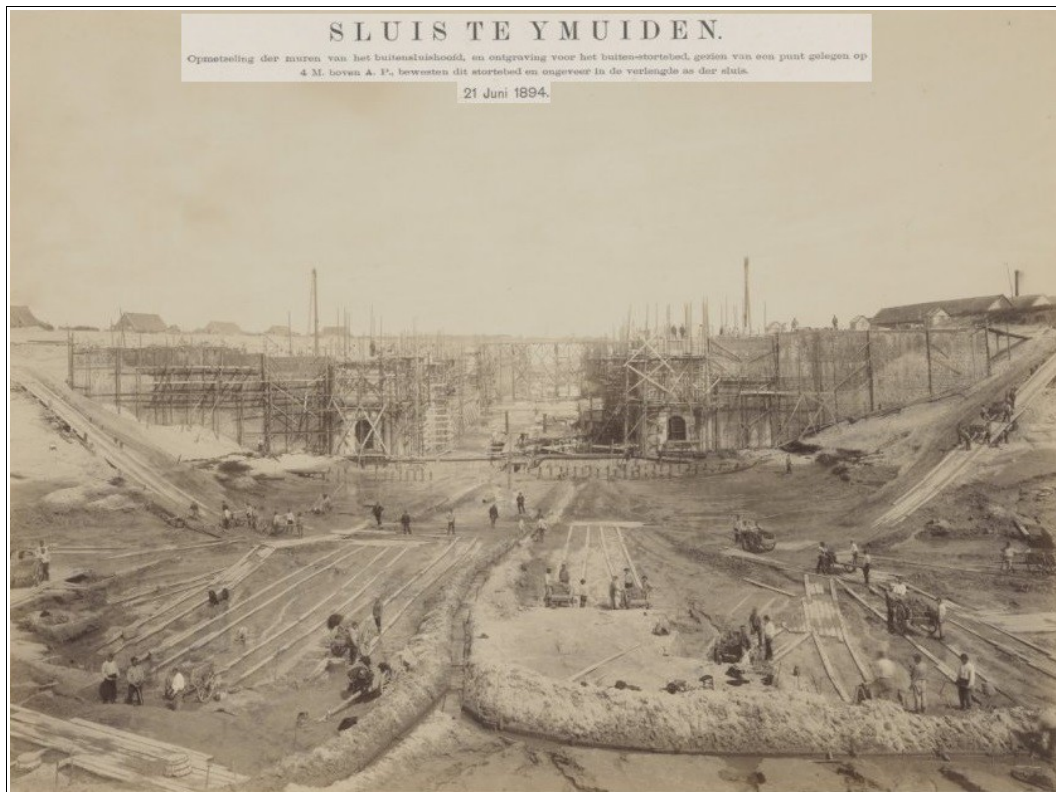
Figuur 6: IJmuiden, Waterkering Sluizen: foto van 21 juni 1894 van de bouw van de Middensluis. Het bijschrift vermeldt: ' Opmeteling der muren van het buitensluishoofd, en ontgraving voor het buiten-stortebed, gezien van een punt gelegen op 4 M. boven A.P., bewesten dit stortebed en ongeveer in de verlengde as der sluis. ' Bron: www.gahetna.nl .
