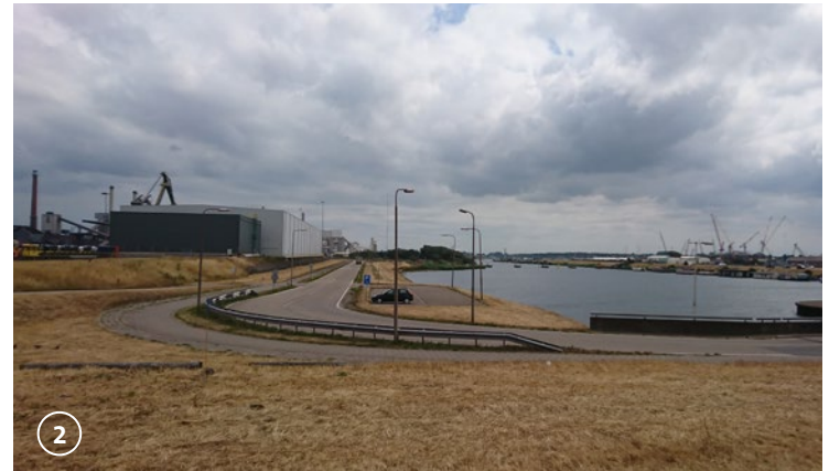
De oever van het Binnenspuikanaal heeft een klein talud en gaat over in een damwand.
