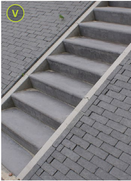
Referentie van trappen in het vlak van de dijk met opsluitbanden ter weerszijde
