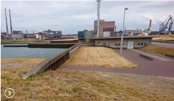
Bij de Spuisluis snijdt het dijklichaam in een keermuur die de waterkering vormt.
