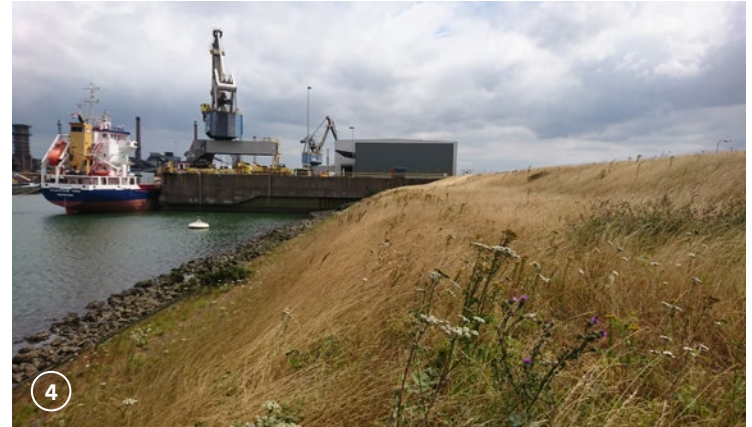
Aan de oostzijde loopt de dijk tegen een haventerrein van Tata Steel aan.
