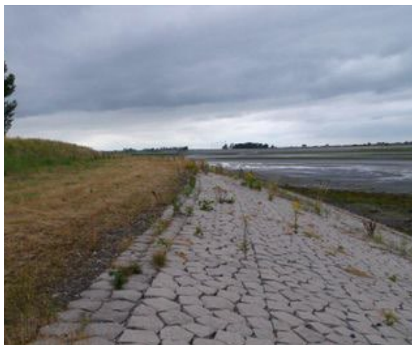
Referentiebeeld ongewenste lijnen in een gewenst onregelmatig patroon in de gesloten steenbekleding (zetsteen)
