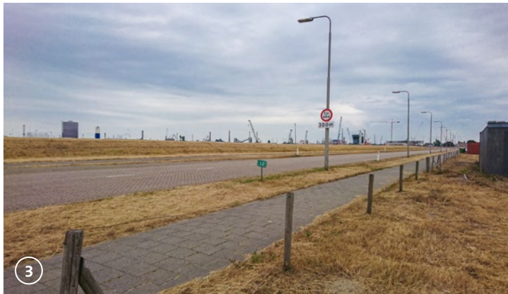
De binnenberm van de dijk met de vele infrastructuurlijnen zorgt voor een stenig beeld. De wegen lopen parallel met het sluiseland en de dijk.
