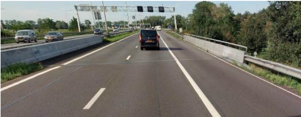
5. Stalen barrier op korte afstand van de rijbaan.
