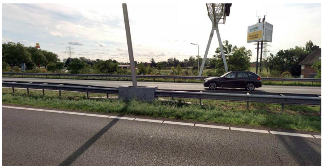
4. Stijve geleiderails met korte, stalen barriers ten behoeve van lichtmasten
