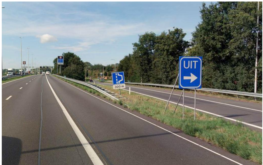
3. Beginpunt geleiderail onvoldoende uitgebogen bij afrit Echt vanaf de hoofdrijbaan rechts.
