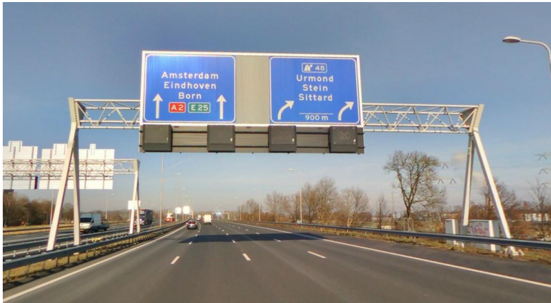
23. Splitsing rijstroken van de hoofdrijbaan links bij aansluiting Urmond
