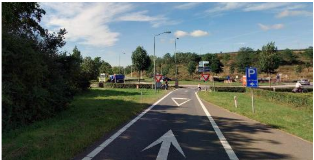
12. Onduidelijke situatie op afrit Echt vanaf hoofdrijbaan rechts door plaatsing van voorrangsborden stroomopwaarts van de fietsoversteek
