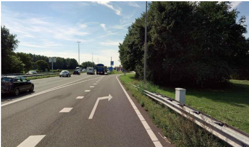
17. Aanwezigheid begroeiing in buitenberm beperkt het zicht op het verloop van de afrit naar verzorgingsplaats 't Anker
