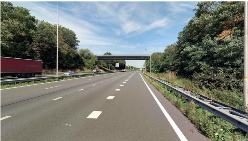
6. Afscherming van bord met status van de spitsstrook
