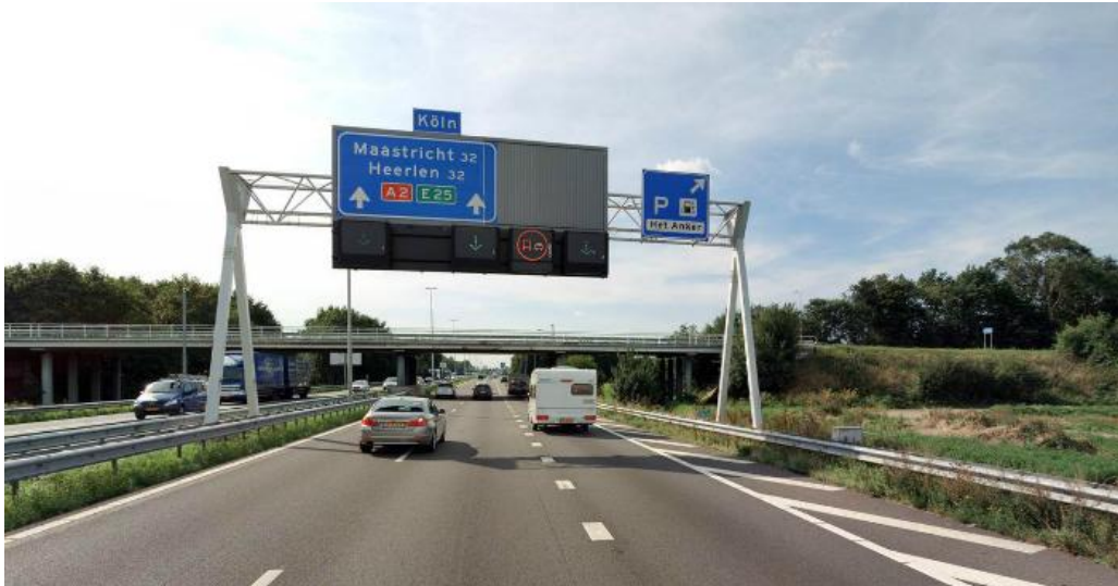
15. en 16. Insnoering dwarsprofiel ter plaatse van viaduct Gebroek (KW 8) waardoor de afrit naar verzorgingsplaats 't Anker pas laat zichtbaar is
