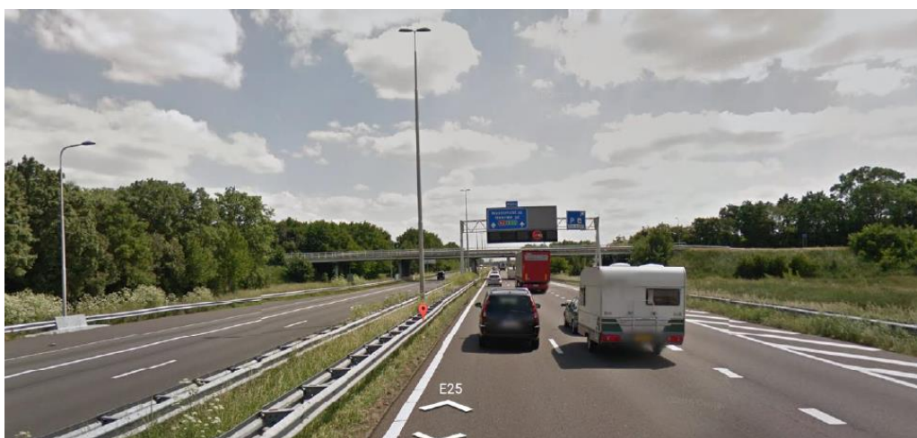
Figuur 6-20 Huidige situatie verlichting met masten in de middenberm
