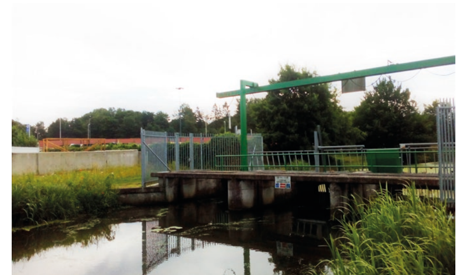
^ A28-Zuid, KW Heiligenbergerbeek: een caravanstalling (links), vuilafvanginstallatie en volkstuincomplex vormen een barrière voor een doorgaande route langs de Heiligenbergerbeek. De lage wegligging van de A28 vormt ook een barrière.
