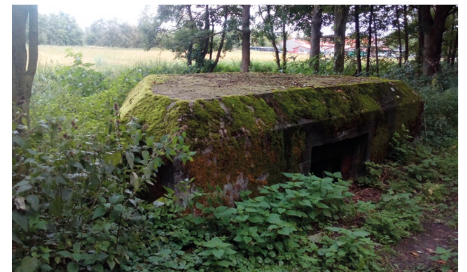
^ Kazemat GLB10, Mosselpad: de A28 doorsnijdt de Grebbelinie van 1745. Deze kazemat ligt verscholen in het groen, de Grebbelinie is vanaf de snelweg niet beleefbaar.
