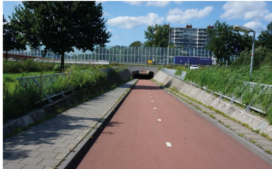
^ A28-Zuid, KW Valleikanaal/Tunnel Schammer: een ruime en prettige verbinding tussen Amersfoort en recreatiegebied De Schammer, gebundeld aan het Valleikanaal. Bij verbreding van de snelweg moet het ruimtelijke beeld behouden blijven.
