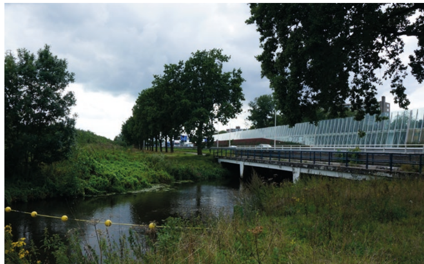
^ A28-Zuid, KW Barneveldse beek: de beken vormen blauwgroene aders naar Amersfoort. Door de zeer lage wegligging is het moeilijk om een recreatieve onderdoorgang te realiseren naast de beken.
