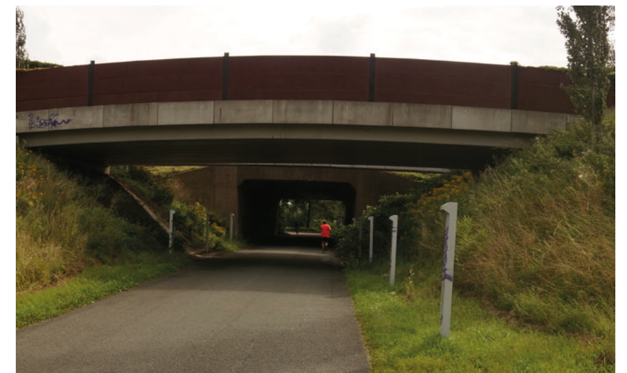
^ A28-Noord, KW Domstraat: een belangrijke verbinding tussen Amersfoort-Noord en het landelijk gebied van Nijkerk. De onderdoorgang is hier al lang door de Verbindingsweg en A28. Ruimtelijke kwaliteit is een belangrijk aandachtspunt.
