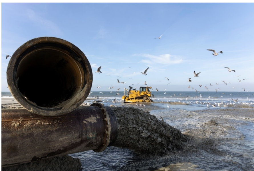
Figuur 1. Een strandsuppletie in uitvoering (foto: Rijkswaterstaat).
