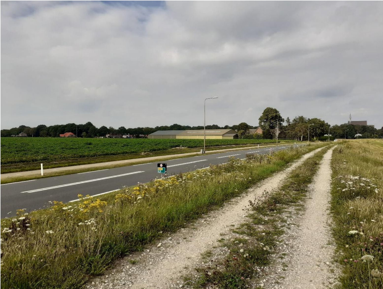
Figuur 6 Primaire kering verschuift van de N271 naar parallel de provinciale weg.
