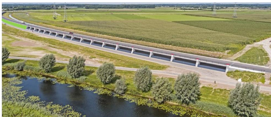
Figuur 62 Indicatie uiterlijk waterkerende instroomvoorziening, gebaseerd op de constructie bij Veessen-Wapenveld
