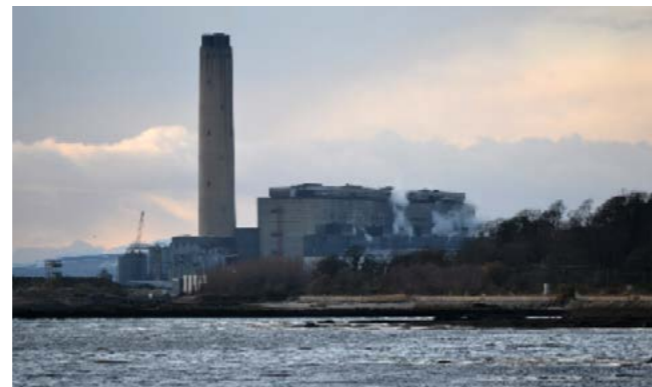
Kolencentrale in Schotland, een voorbeeld van een mogelijke bron van zware metalen
