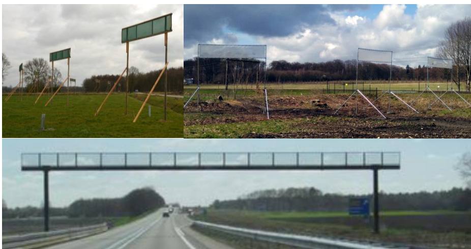
Afbeelding 11: Voorbeelden van tijdelijke, geleidende structuren voor vleermuizen.
