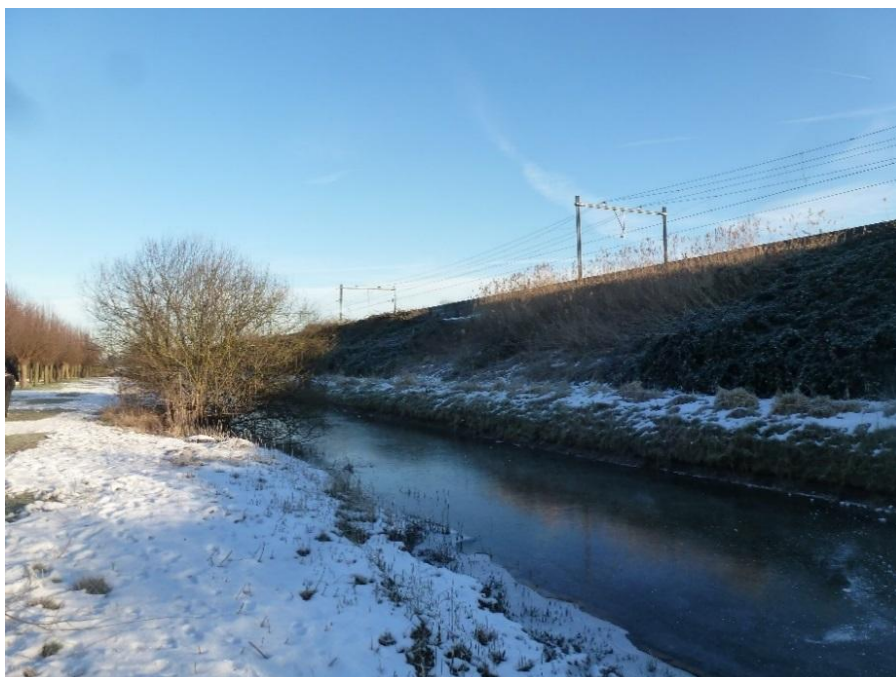
Figuur 1: Spoortalud bij Waardenburg, ter hoogte van de Dokter van Wieringestraat.
