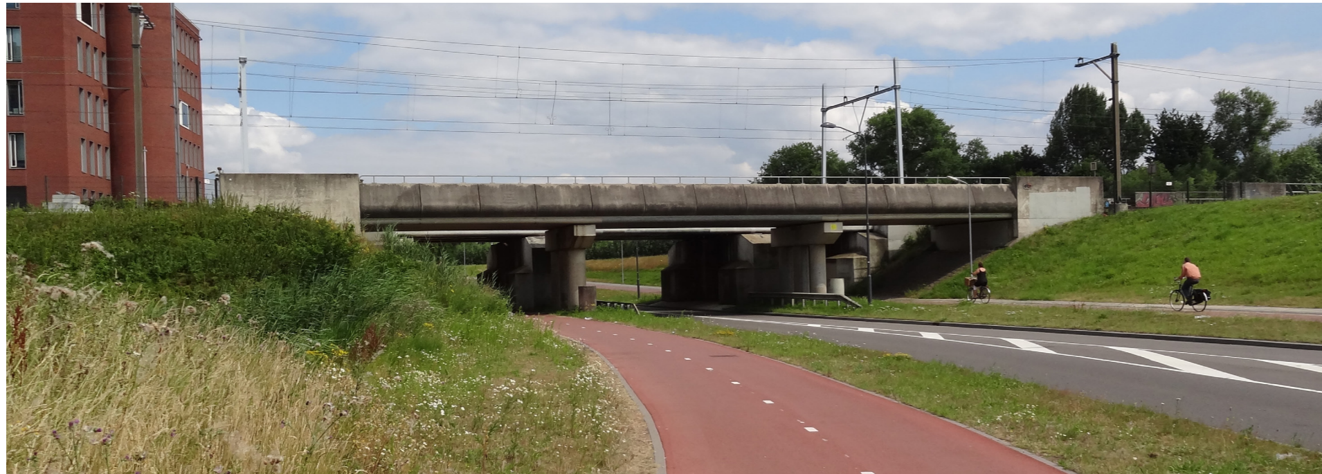
SPOORBRUGGEN OVER VLIJMENSEWEG
