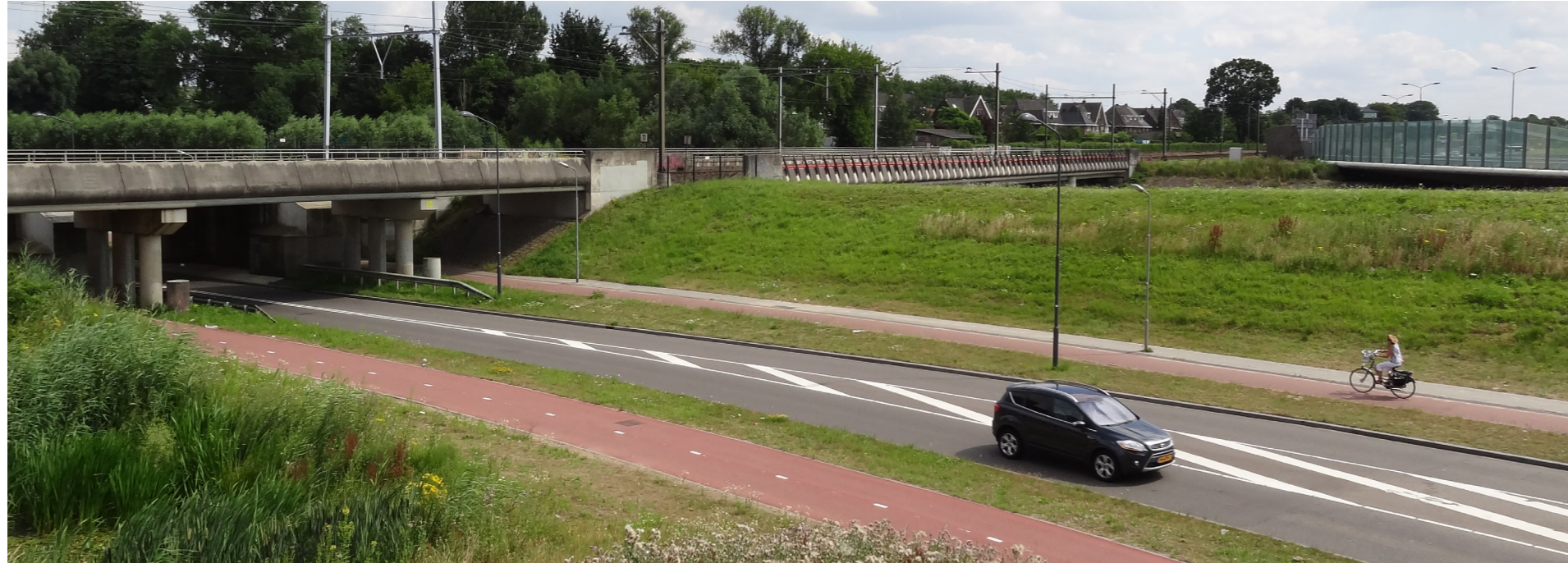
SPOORBRUGGEN OVER VLIJMENSEWEG EN DRONGELENS KANAAL
