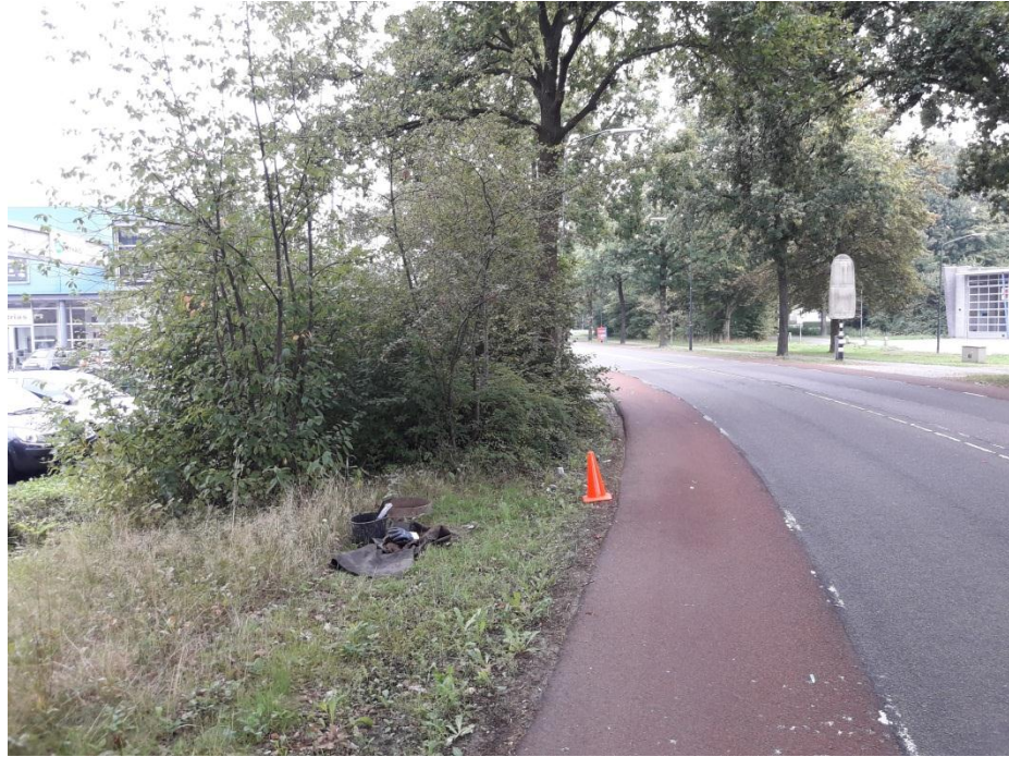
Figuur 3.2 Zicht op sectie 7 vanaf het zuiden in noordelijke richting.
