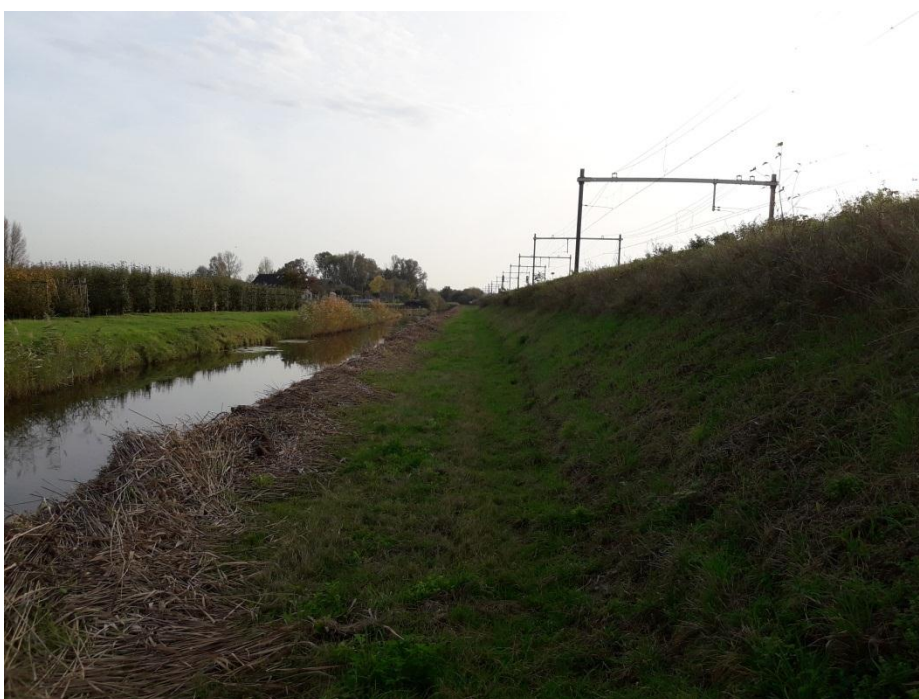
Figuur 3.6 Zicht op het schouwpad vanaf boring 41 in zuidelijke richting.
