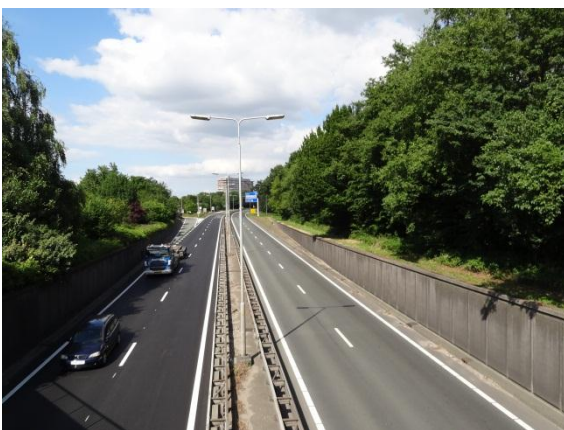
Foto 28 Verdiepte N65 bij kruising spoorlijn
