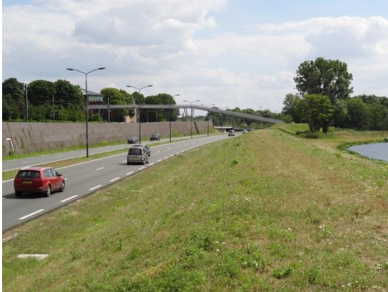
Foto 20 Spoor, randweg en afwateringskanaal
