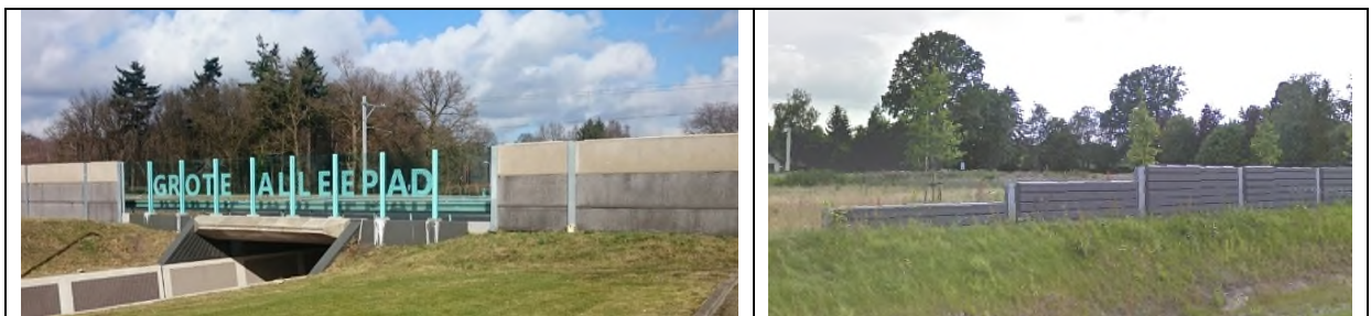
Figuur 7.4: Geluidwering type Combiplan, met rechts de getrapte opbouw
