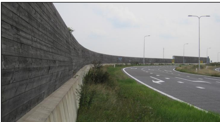
Figuur 5.4 De bestaande geluidschermen bij Wierden.
