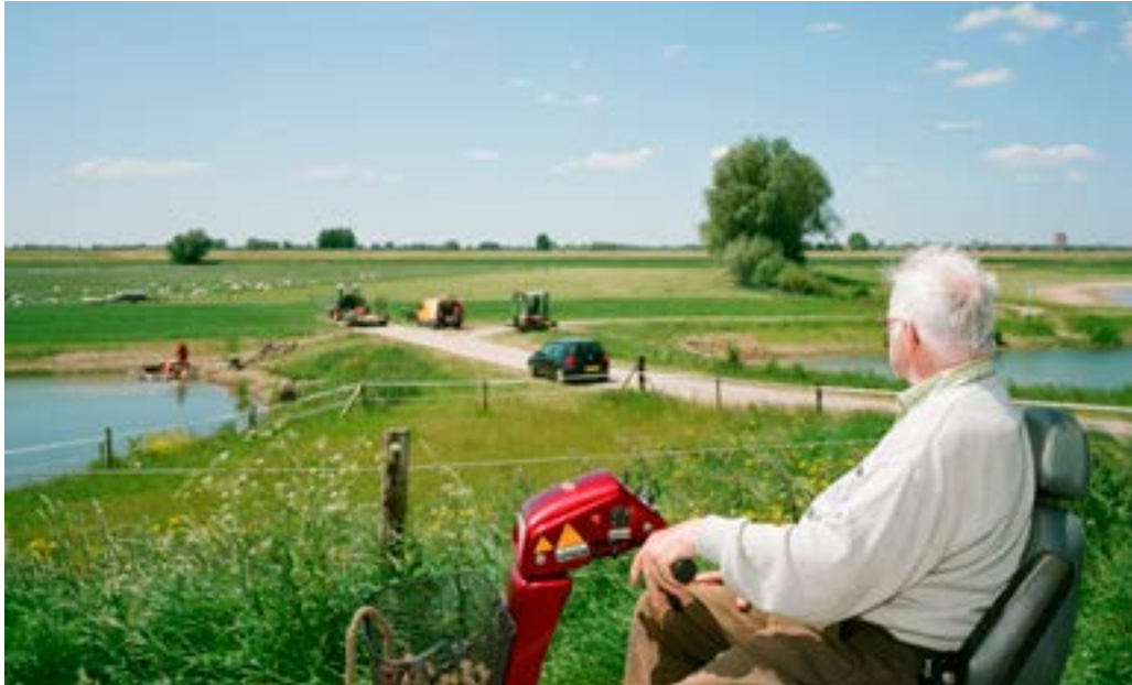
Herinrichting van polder Hondsbroeksche Pleij; middels een overlaat kan er extra water naar de IJssel geleid worden.
