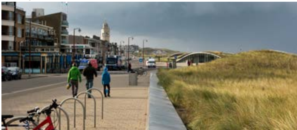
Dubbel ruimtegebruik: In de multifunctionele waterkering in Katwijk is een parkeergarage onder de boulevard gerealiseerd.
