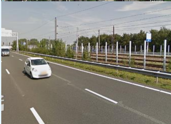
figuur 1: locatie spoor ter hoogte van Badhoevedorp in middenberm A4 en de anti-verblindingspalen langs de A4
