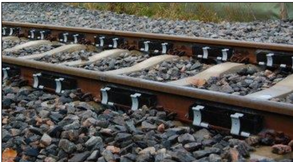
Figuur BI.2 Voorbeeld van de bronmaatregel raildempers.
