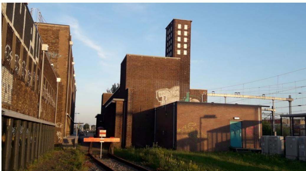
Figuur 3.7 Onderstation (gebouw met toren rechts op de foto) aan het stationsplein bij station Uitgeest dat mogelijk gesloopt gaat worden. Het gebouw links op de foto is een elektriciteitsverdeelstation van Liander dat ook in het onderzoek is meegenomen.
