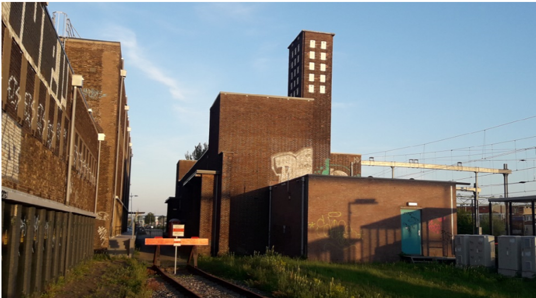
Figuur 4.33 Onderstation (gebouw met toren rechts op de foto) aan het stationsplein bij station Uitgeest dat gesloopt gaat worden. Het gebouw links op de foto is een elektriciteitsverdeelstation van Liander dat ook in het onderzoek is meegenomen.
