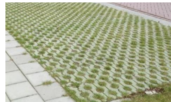
Figuur 23 huidige bestrating parkeerterrein
