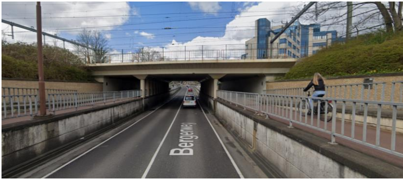
Figuur 4.24: Huidige situatie zuidkant spoorwegviaduct Bergerweg (Bron: Google Maps)
