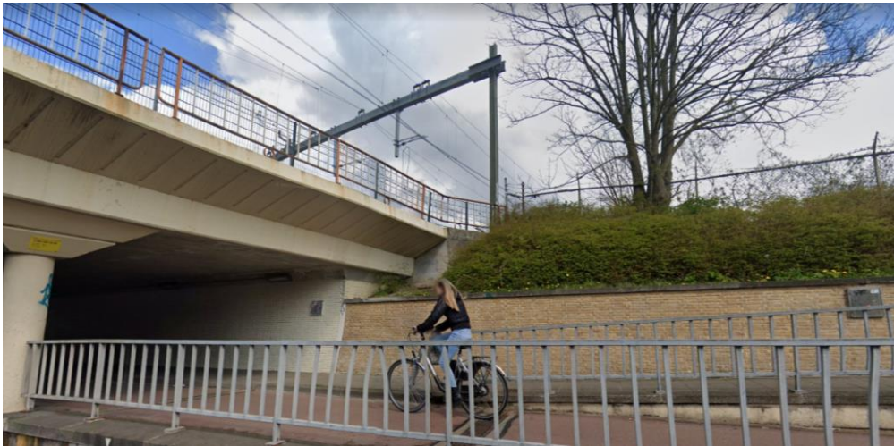
Figuur 4.26 Hekwerk langs de rand van het spoorwegviaduct, om wandelpad te flankeren (Bron: Google Maps)
