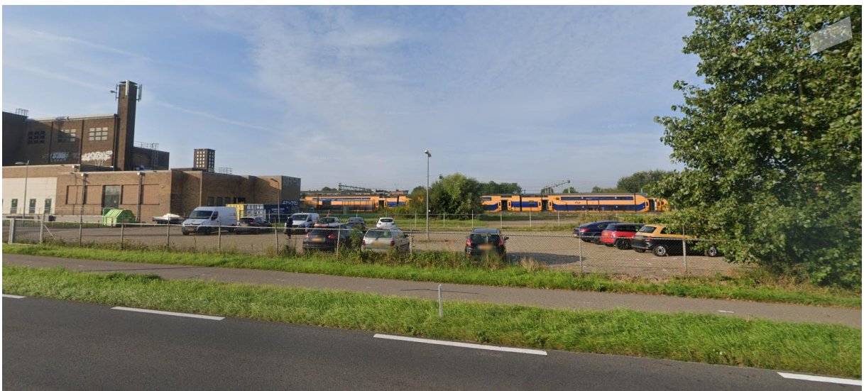
Figuur 4.17 Bouwlocatie relaishuis en onderstation. (Bron: Google Maps)
