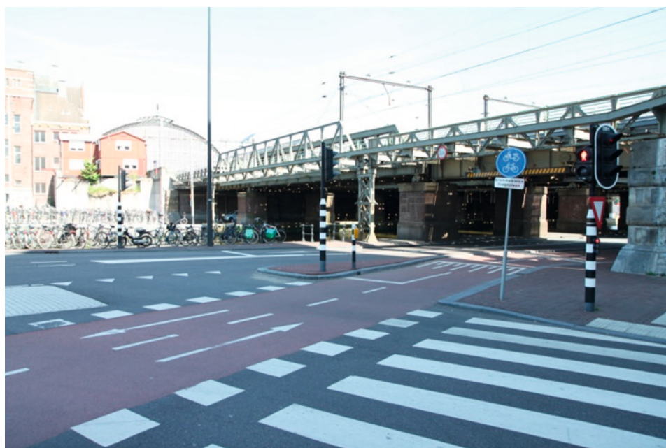
Figuur 4-6. Zuidzijde Oostertoegang
