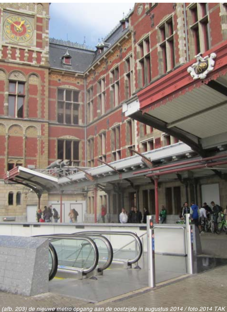
(afb. 203) de nieuwe metro opgang aan de oostzijde in augustus 2014 / foto 2014 TAK
