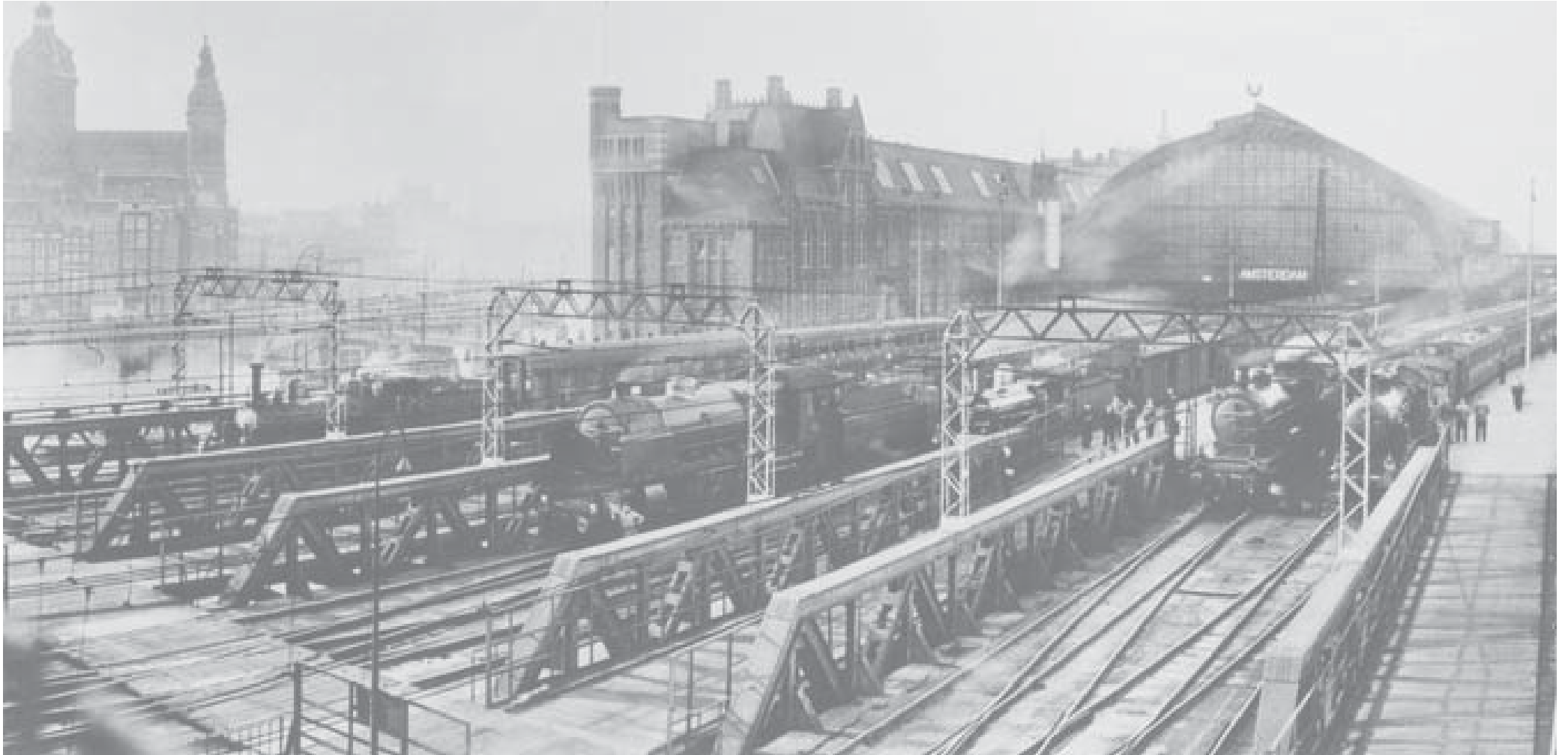
(afb. 46) overzicht van de spoorbruggen over de oosterdoorgang na de eerste grote uitbreiding van het station / foto 1939 GAA
