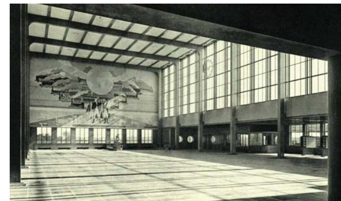
(afb. 48) de lichte en ruime hal van het Amstel station / foto 1939 HUA
