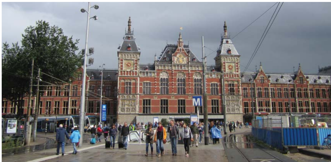
(afb. 1) zicht vanaf het stationsplein op de gevel van het Cuypersgebouw / foto 2014 TAK
