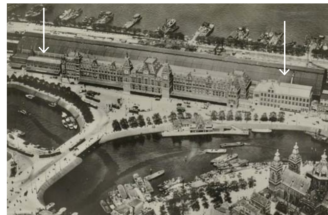
(afb. 132) foto uit 1923 tijdens de bouw van gebouw De Oost (rechts); links op de foto is de westelijke tegenhanger te zien van de goederenvleugel die aan de oostzijde ten behoeve van de bouw van gebouw De Oost moest worden gesloopt / ansichtkaart 1923 SWM
