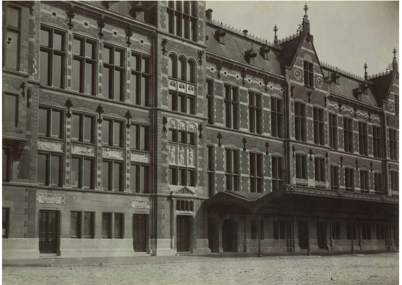
(afb. 95) detail van de voorgevel van het station: door materialisering en ornament ontstaat een levendig beeld. Ook zijn ter plaatse van de toegangen de treden te zien die nodig zijn om het stationsgebouw, dat iets verhoogd ligt ten opzichte van het pleinniveau te kunnen betreden. / foto 1889 SWM
