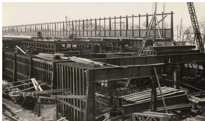
(afb. 135) aanleg van het IJgebouw / foto 1920 SFA
