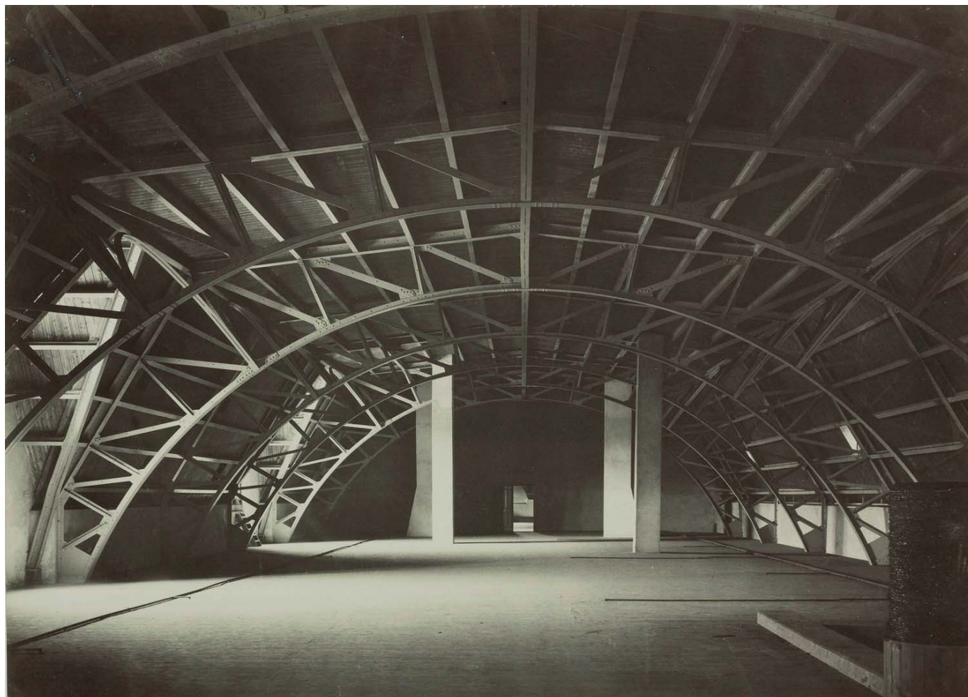
(afb. 114) de opslagruimte onder de kap / foto 1889 SWM
