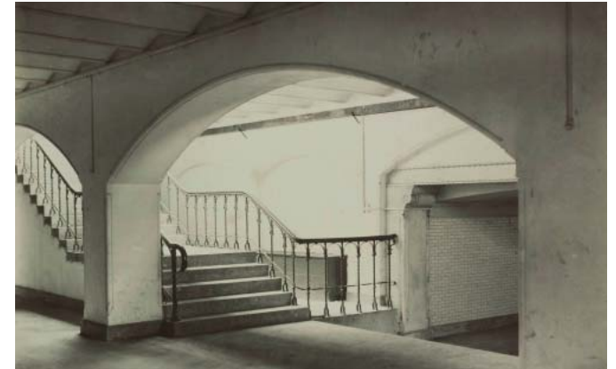
(afb. 125) zicht vanuit de ruimte onder het 1ste perron met links de opgang naar het 1ste perron en rechts de toegang tot de tunnel / foto 1889 SWM
