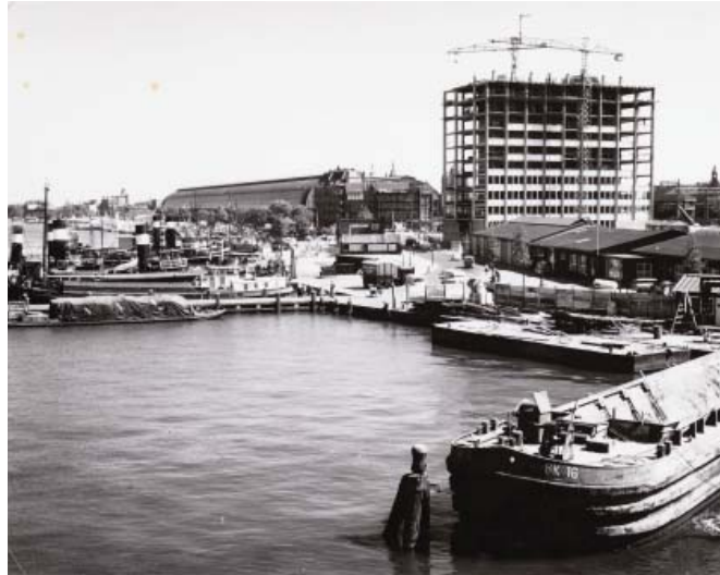
(afb. 61) overzicht van de Ruyterkade met centraal op de achtergrond de overkappingen van het Centraal Station en rechts het Havengebouw in aanbouw / foto 1981 GAA
