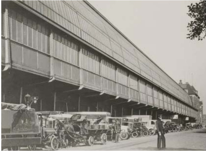
(afb. 35) zicht langs de gevel van het IJgebouw waar men laadt en lost / foto 1929 GAA
