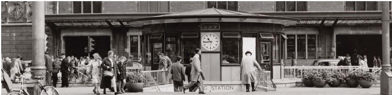
(afb. 153) zicht op de entrees tot het station na 1959 met op de voorgrond de toegangen tot de tunnel en op de achtergrond links en rechts de grote portieken onder de nieuwe, plexiglazen luifel / foto 1955 GAA
