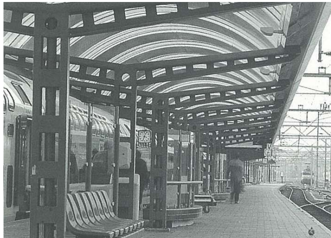
(afb. 75) zicht langs de spanten van de overkapping / 1995 Bouwen met Staal
