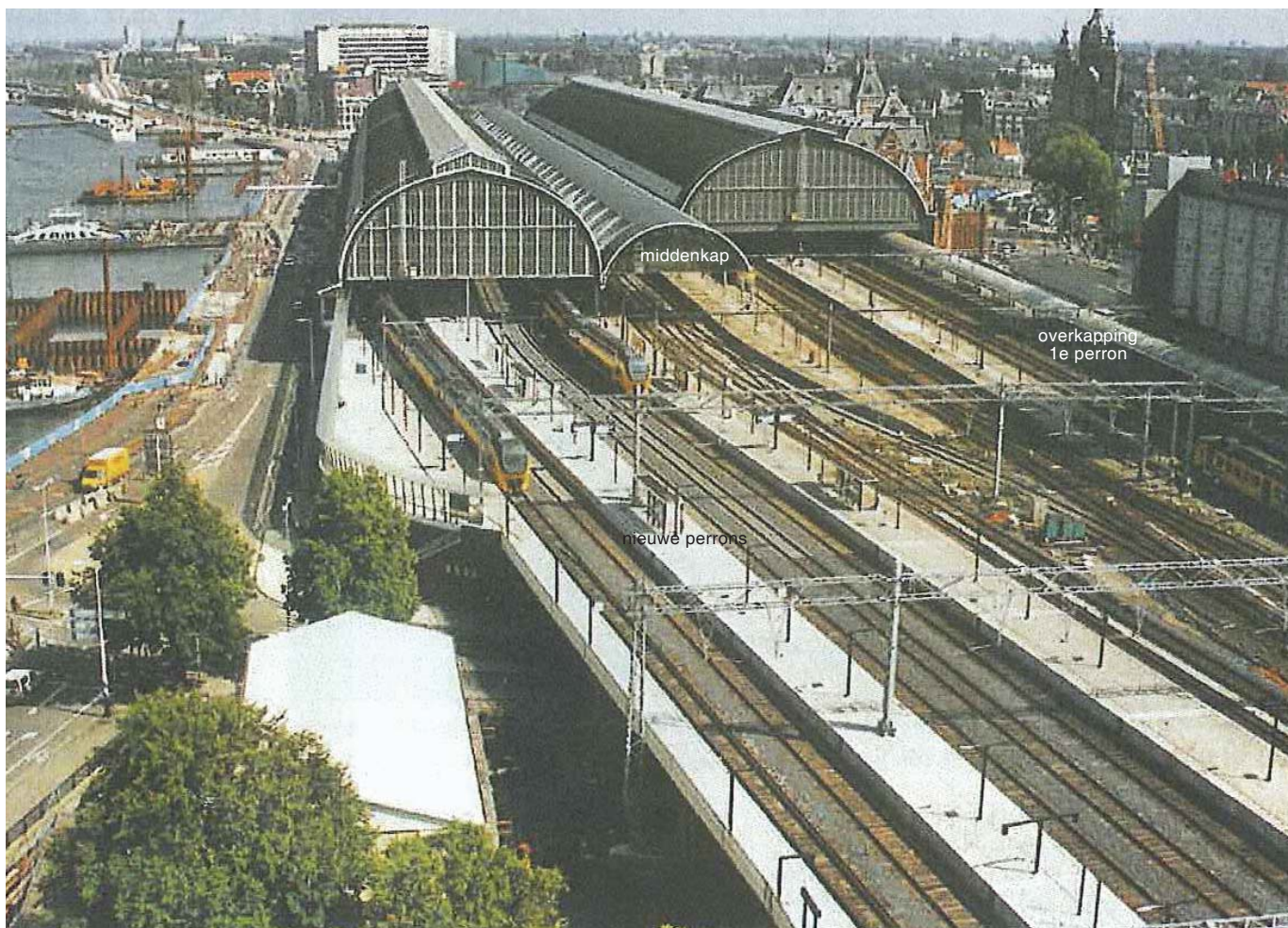
(afb. 81) zicht vanaf hetzelfde punt, het Havengebouw, op de noordwesthoek van het middeneiland in 2004 ná voltooiing van het project, waar op de voorgrond is te zien dat het Gebouw Ruyterkade is gesloopt en er een aanzienlijke perronlengte is toegevoegd / foto 2004 Op de Rails
