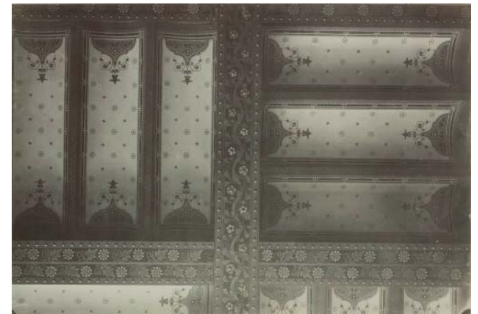
(afb. 107) detail van het fraai gedecoreerde plafond, bestaande uit gepleisterde metselwerken troggewelfjes tussen stalen constructie / foto 1889 SWM
