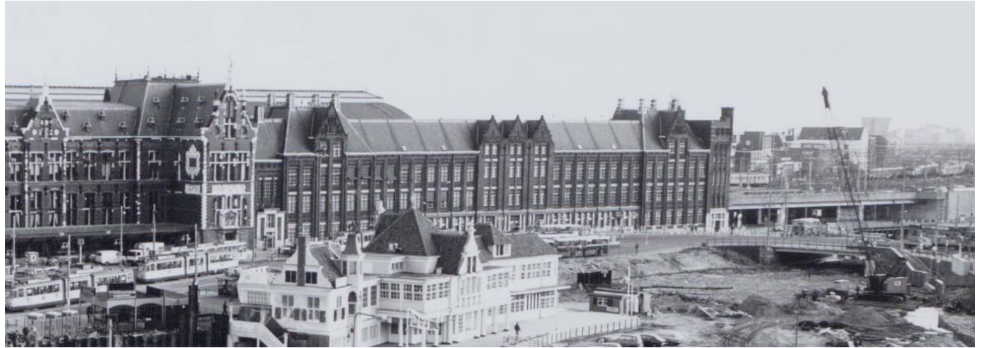
(afb. 36) de voorgevel van het Cuypersgebouw met rechts gebouw De Oost / foto 1981 RCE
