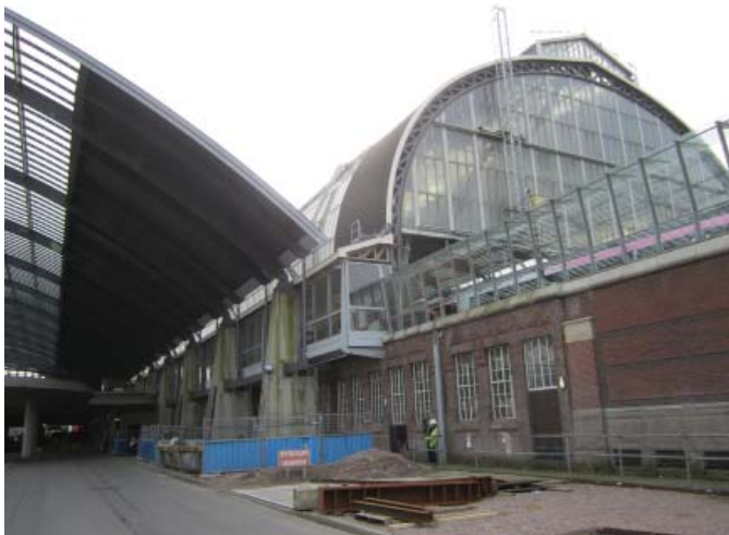
(afb. 3) zicht op de westelijke kop van het IJgebouw / foto 2012 TAK
