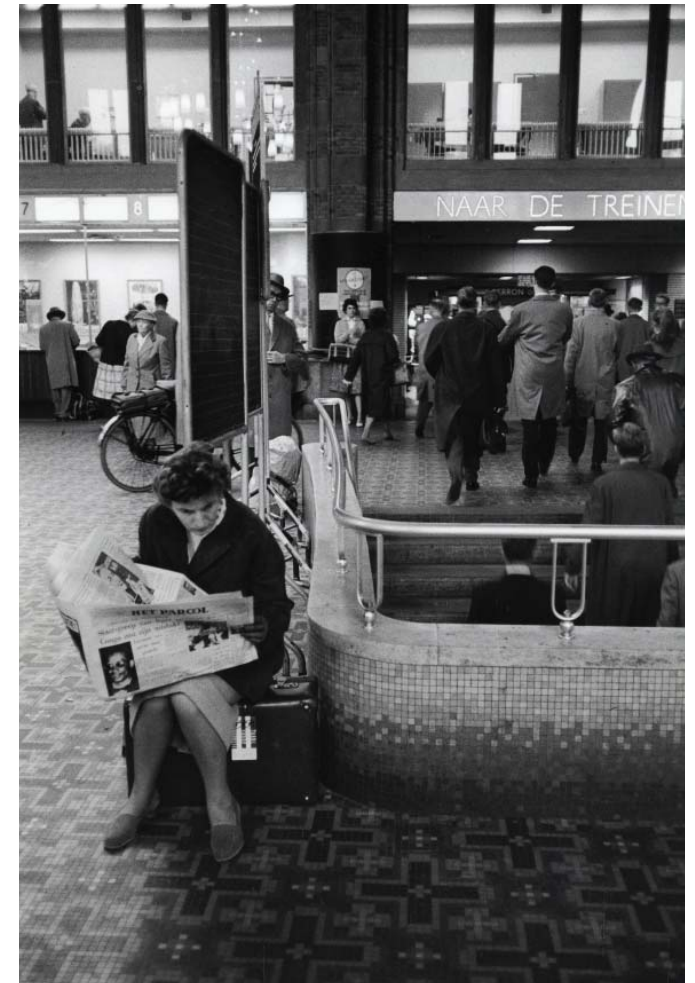
(afb. 160) zicht langs de opgang vanuit de voetgangers richting de toegang tot de middentunnel / foto 1960 GAA
