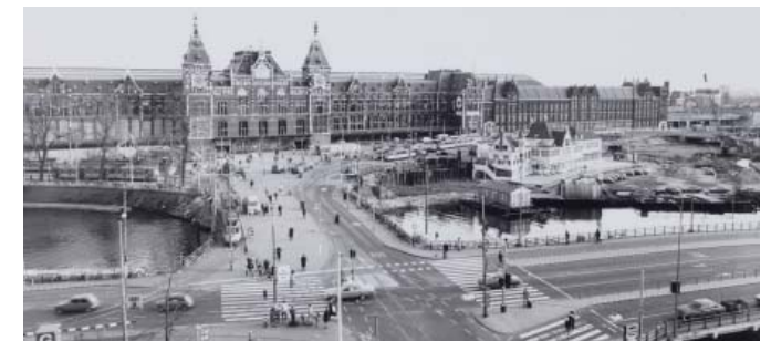
(afb. 59) overzicht van het voorplein tijdens de werkzaamheden aan het metrostation Centraal / foto 1881 GAA
