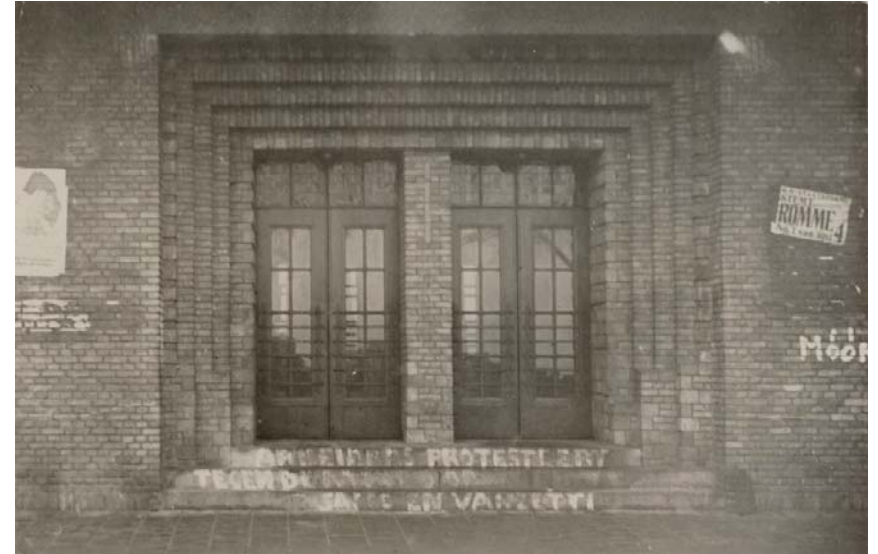
(afb. 138) foto van de entree in de gevel van het IJgebouw ter plaatse van de middentunnel, oor die door middel van een metselwerken omlijsting is verbijzonderd / foto 1927 SWM
