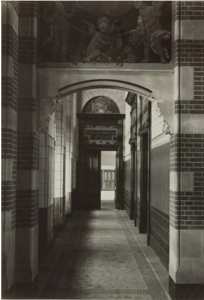
(afb. 100) zicht op de toegang van de restauratie, links is de overgang te zien van schoon metselwerk naar geschilderd metselwerk / foto 1889 SWM
