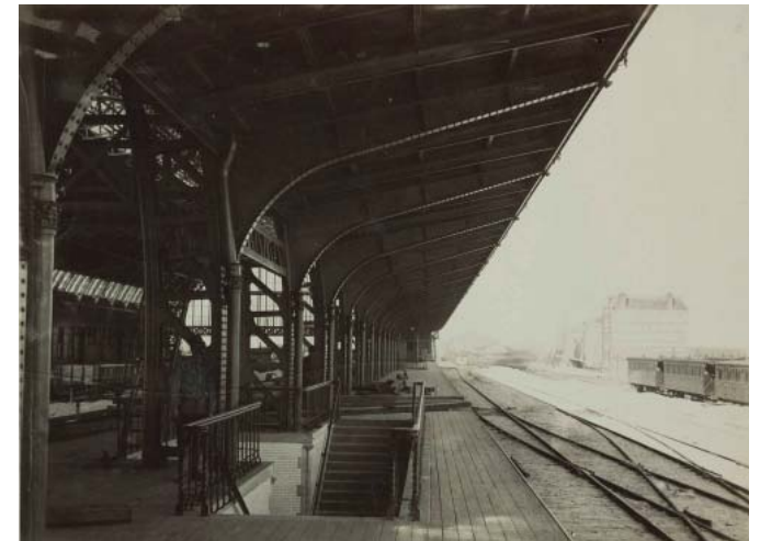
(afb. 126) zicht op de trapopgang vanuit de middentunnel naar het 3de perron / foto 1889 SWM
