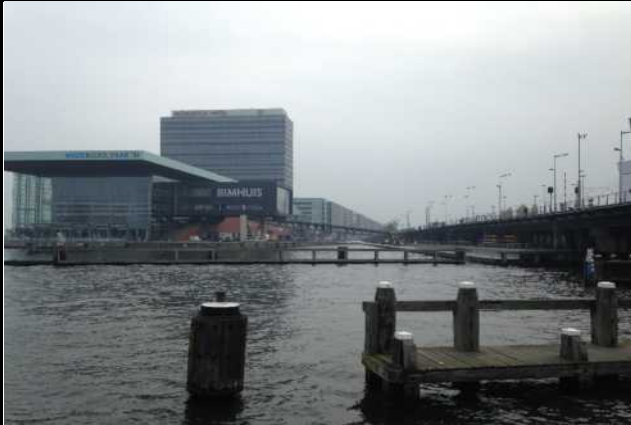
Zicht op het herontwikkelde gebied langs de Oostelijke Handelskade. Op de kop zat in het verleden de Hollandse Stoombootmaatschappij. Gezien vanaf De Ruijterkade langs het IJ in oostelijke richting.
