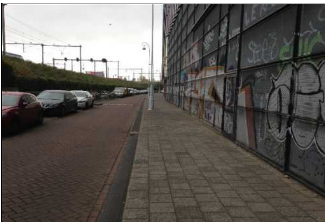
Zicht op de Keerwal. Rechts de locatie welke nog in eigendom is van NS-Vastgoed. Ter plaatse is een verdeelstation aanwezig.
