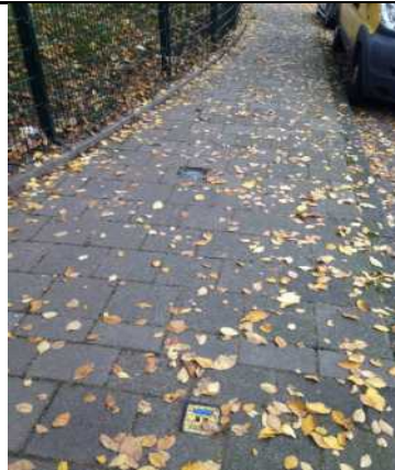
In het trottoir van de Westerdokskade zijn nog diverse peilbuizen van de afbakening van Wbb-geval 427.WG5 (kern D, VLTC-terrein)
