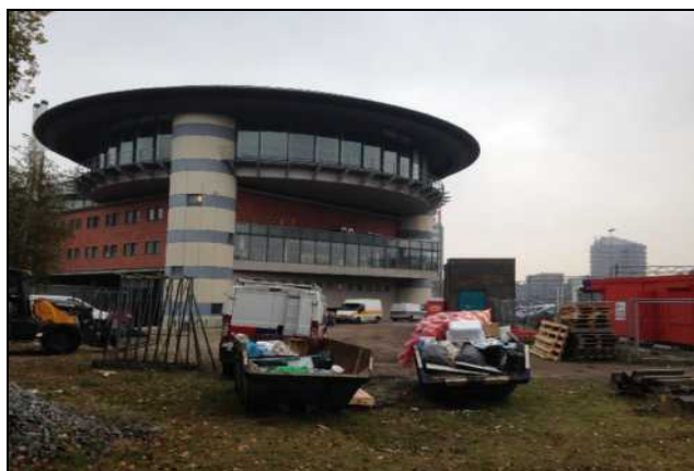
Zicht op het VLTC-gebouw en het werkterrein van Strukton. Gezien in oostelijke richting.
