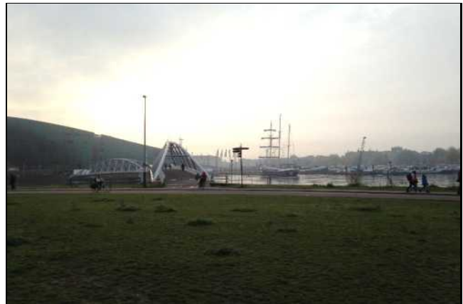
Zicht in oostelijk richting op Oosterdoksdraaibrug. Gezien vanaf Oosterdokskaade.
