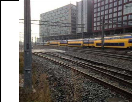
Zicht op de spoorbanen tussen het Oosterdokeiland en het station. Gezien van het schouwpad aan de noordzijde van het spoor.
