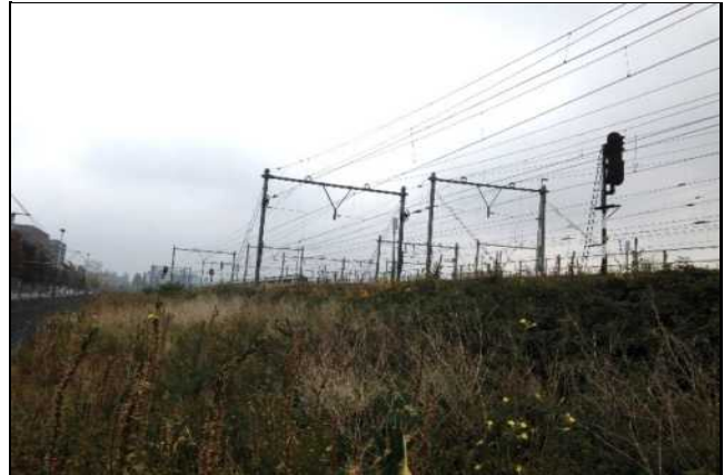
Zicht op de tramspoorbanen en het hoogteverschil met de omgeving. Gezien in oostelijk richting vanaf de spoordijk.
