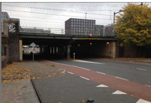
De spoorbrug over de Kattenburgstraat, gezien vanaf de Dijkgracht, in noordelijke richting.
