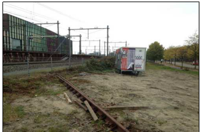
Zicht op de spoorbanen, met zichtbaar het hoogte verschil tussen beide sporen, en een grotendeels verwijderd werkkerrein. Gezien in noordelijke richting.
