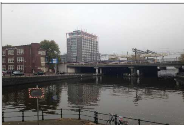
Zicht op de spoorbrug over de Westertoeegang. Gezien vanaf de Prins Hendrikkade in noordwestelijke richting.
