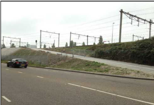
Bouwweg naast het spoorviaduct over de Borneolaan. Gezien vanaf de Frans de Wollantstraat in noordelijke richting.
