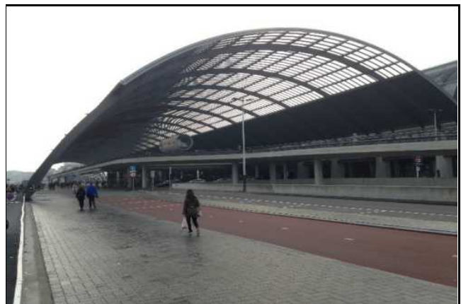
Zicht op het overdekte busstation en het stationsgebouw vanaf de kade langs het IJ (De Ruijterkade). Gezien in oostelijke richting.
