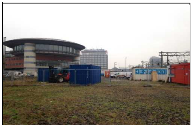
Zicht op het VLTC-gebouw met op de voorgrond het werkterrein van Strukton, de vroegere locatie van het dienstgebouw en de tankplaat.
