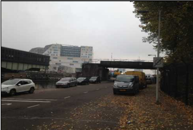
Zicht op de voormalige spoorbrug Westerdokseiland (brug nr. 19S). Gezien vanaf de Westerdokskade in oostelijke richting.
