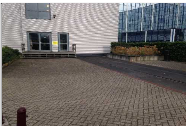
Zicht op de oostzijde van het VLTC-gebouw.
