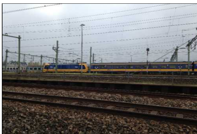
Zicht op emplacement Dijkgracht wat gebruikt wordt als rangeertrein. Gezien vanaf het schouwpad in zuidwestelijke richting.
