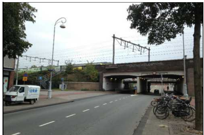
Spoorviaduct over de Cruquiuskade met links de Keerwal. Gezien vanaf de Cruquiuskade in oostelijke richting.
