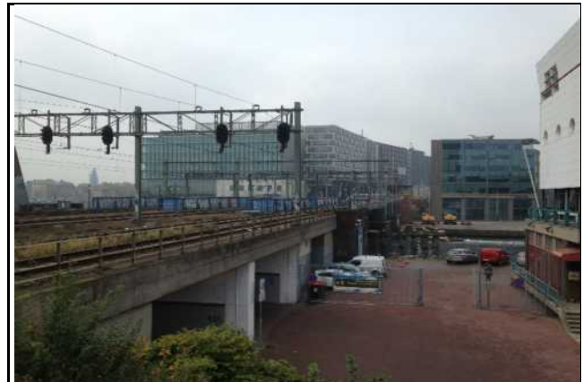
Zicht op de spoorbrug over de Oosterdoksdoorgang met rechts het ventilatiegebouw van de IJ-tunnel. Gezien in westelijke richting.
