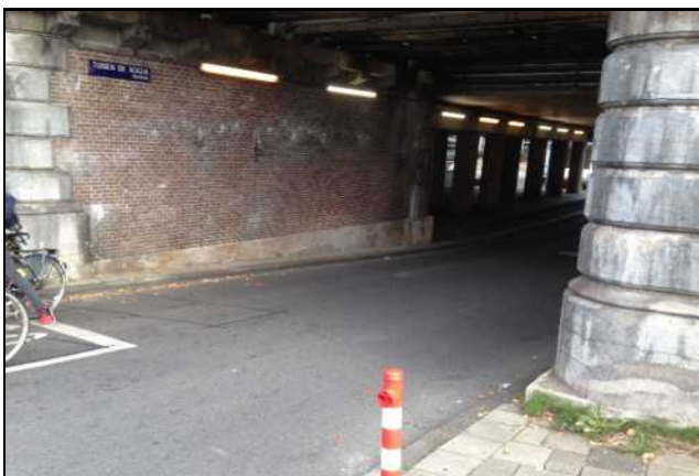
Doorgang onder het spoor, Tussen de Bogen. Gezien in noordelijke richting. Omgeving Wbb-gevallen 427.WG2 en 427.WG3.
