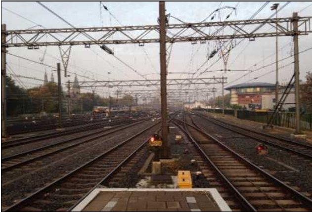
Zicht op de spoorbanen richting het westen vanaf perron 13a/14a. Op de achtergrond het VLTC-terrein (ProRail).
