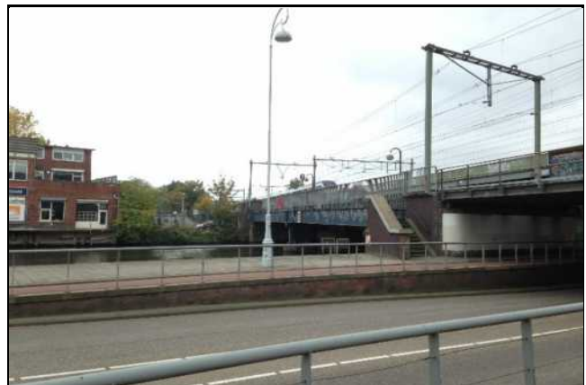
Spoorviaduct over de Cruquiuskade en spoorbrug over de Nieuwevaart gezien in zuidelijke richting (op de achtergrond het Zeeburgerpad).
