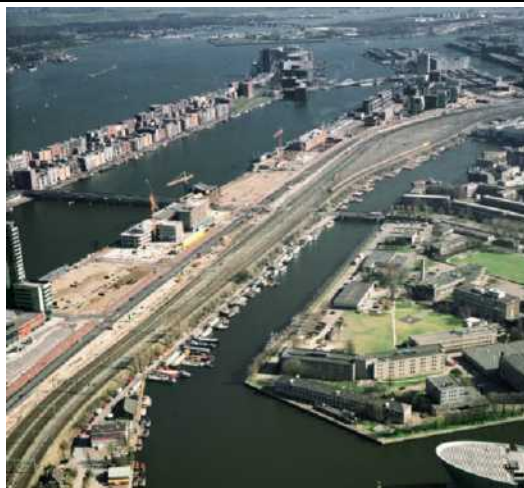
Abbeelding 1.12: Luchtfoto van de Dijkgracht (midden) met links de Piet Heinkade, de sporen naar het centraal station en de ontwikkelingsprojecten langs de kade en de Rietlanden. Gezien in oostelijke richting (2003).
