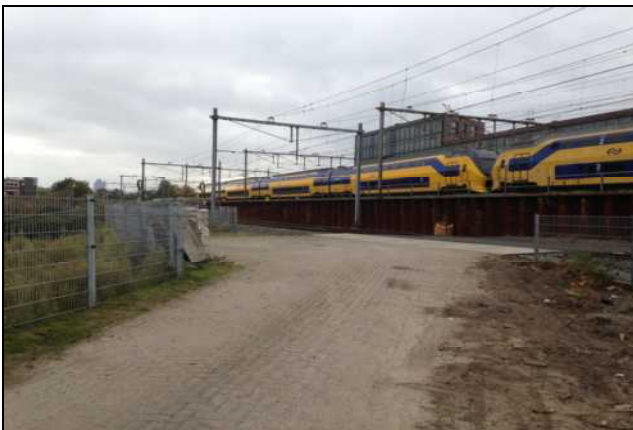
Verharde bouwweg naar de spoorbaan. Gezien vanaf de Panamalaan in westelijke richting.
