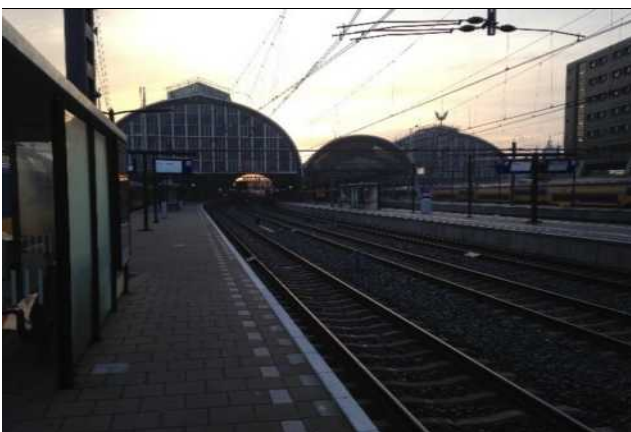
Zicht richting het stationsgebouw (oosten) vanaf perron 13a/14a.
