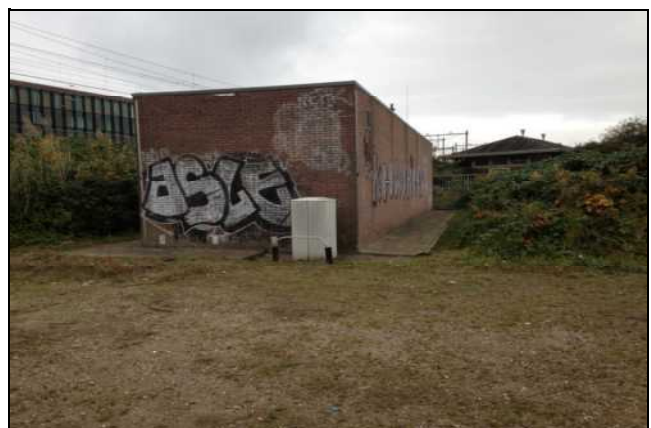
Zicht op het monumentale pand van het ontsmettingsgebouw (Loyd) op Oostelijke Handelskade 34B. Gezien in zuidelijke richting.
