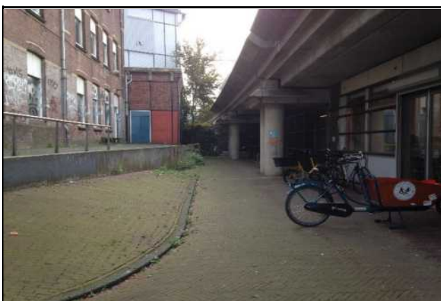
Zicht op Tussen de Bogen (locatie Wbb-geval 427.WG3). Gezien in oostelijke richting vanaf de Grote Bickerstraat.
