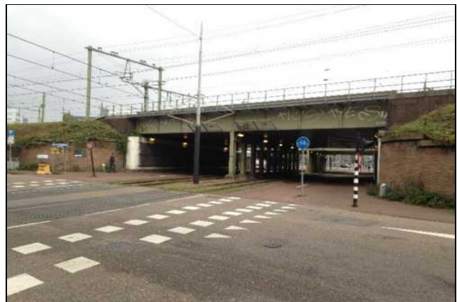
Spoorviaduct over de Czaar Peterstraat. gezien in noordoostelijke richting
