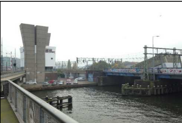
Zicht op de spoorbrug over de Oosterdoksdoorgang met links het ventilatiegebouw van de IJ-tunnel. Gezien in zuidoostelijke richting.
