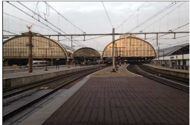
Zicht richting het stationsgebouw (oostzijde) vanaf perron 13b/14b.
