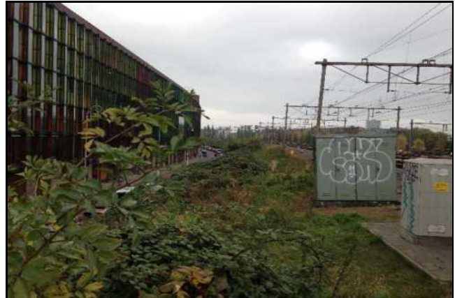
Zicht op de Keerwal vanaf het schouwpad (spoordijk). Gezien in noordelijke richting.
