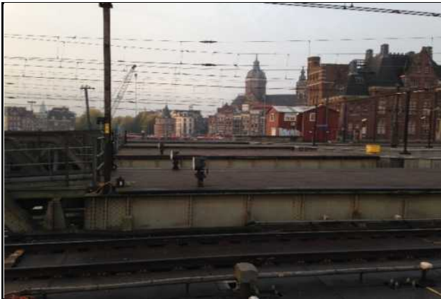
Zicht richting het zuiden (centrum) vanaf perron 13a/14a.
