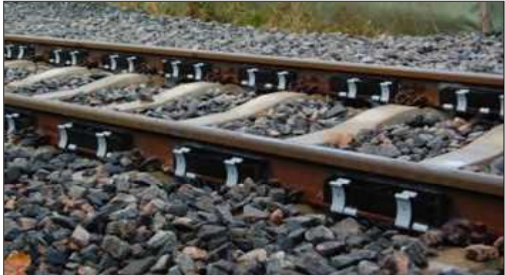
Figuur I-2 Een voorbeeld van de bronmaatregel raildempers. Dit zijn de zwarte rubberen blokken die in dit geval tegen de rails worden geklemd.
