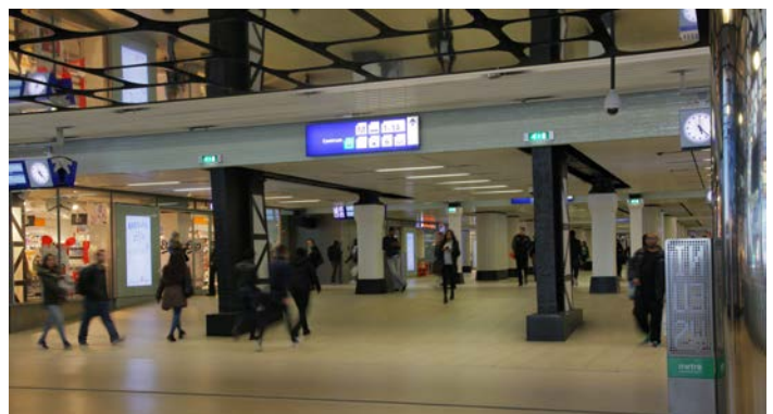
Middentunnel ter hoogte van het IJgebouw
