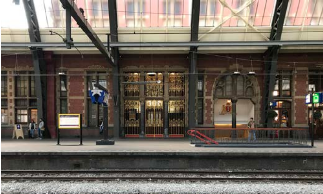
Perron 1 met gemetselde perronwand en stijgpunt met oorspronkelijk stalen hekwerk
