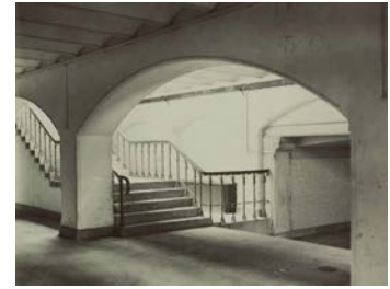
Bogenwand ter hoogte van de middentunnel - 1889
