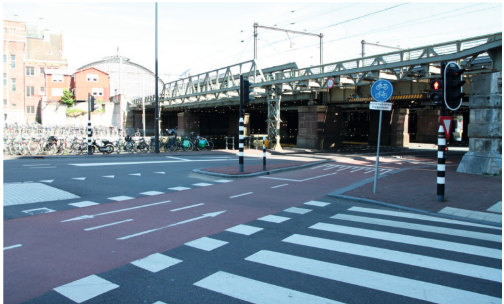
Figuur 1-9. Zuidzijde Oostertoegang
