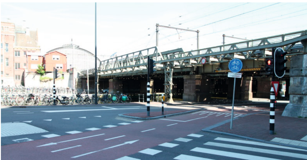
Figuur 3-7. Zuidzijde Oostertoegang
