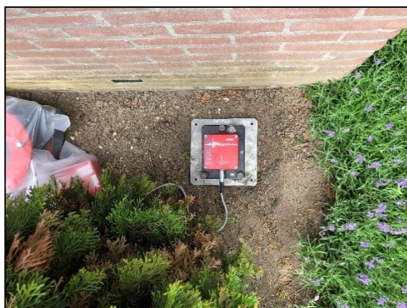
Figuur 3.11: Meetpunt maaiveld (MT37) naast de woning Stationsweg.
